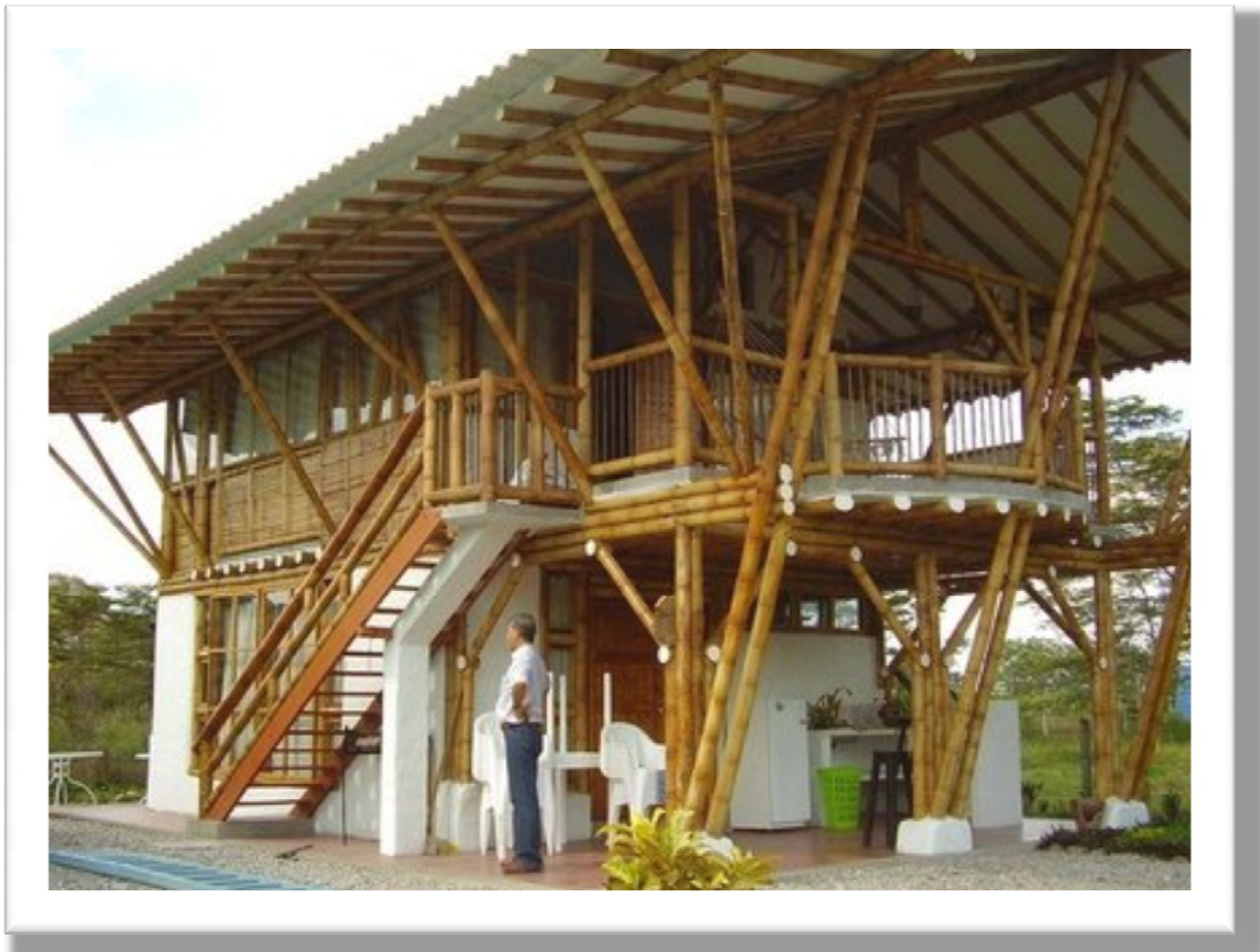
Imagen Instalaciones con Infraestructura en Guadua www.usobambuquadua.com
