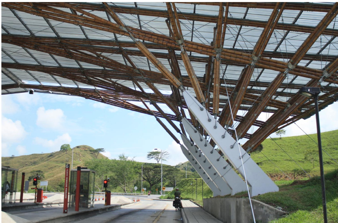
Imagen Utilizando Guadua en Peaje www.miniagricultura.gob.co
