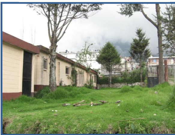
Foto 3: Área Libre Puesto de Salud en desuso, Sibinal
