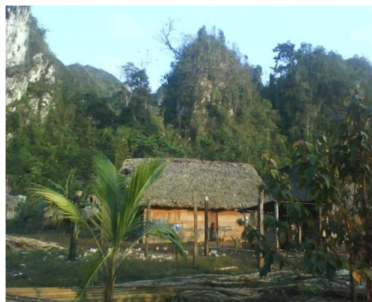
Fotografía de la vivienda rural q'eqchí ubicada en la aldea Semox Yalicar, Chisec Alta Verapaz, 2011. Los materiales con que está construida la vivienda son: muros de madera, puertas de madera, techo de hoja de manaco, cimentación ciclópea.
