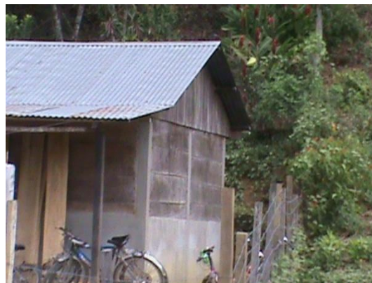
Vivienda rural q'eqchí ubicada en la aldea Samococh, Chisec, Alta Verapaz, 2011 donde se observan los materiales de la vivienda rural con techo de lamina, muros de madera y concreto, mojinete de madera, puertas y ventanas de madera.
