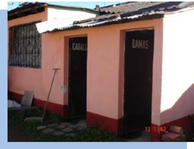
Fotografía No. 4 Instalaciones deficientes Municipalidad de Santa Cruz Balanya Fuente: Elaboración propia
