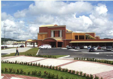
FIGURA No. 11: ( www.cyberbuses.galeon.com , abril de 2010) En la imagen se observa el manejo de la aproximación al edificio con una gran plaza de ingreso y la ubicación del parqueo de servicio al frente sin interferir con las circulaciones de los vehículos pesados.
