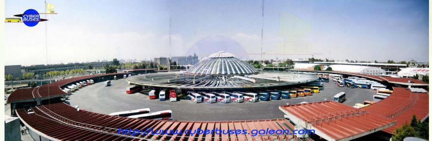
FIGURA No. 10: ( www.cyberbuses.galeon.com , abril de 2010) Planta en la que las circulaciones se encuentran de manera radial con plazas a 60 grados que facilita la movilidad de los vehículos
