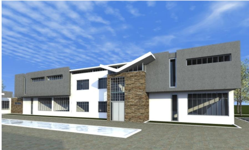
VISTA FRONTAL MODULO DE AULAS
