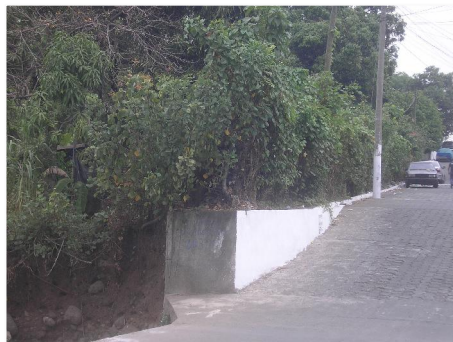
VISTA DEL PUENTE HACIA EL TERRENO
