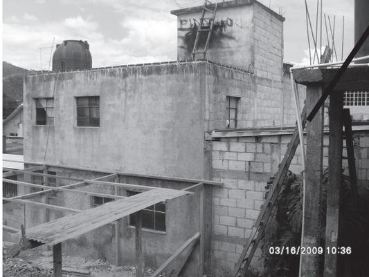
EN la parte posterior se nota de manera desordenada e inadecuada las tuberías de agua potable y hierros aun expuestos.
