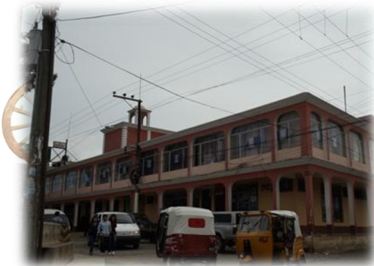
Imagen No. 12 Palacio Municipal Zaragoza Fuente: Elaboración propia.
