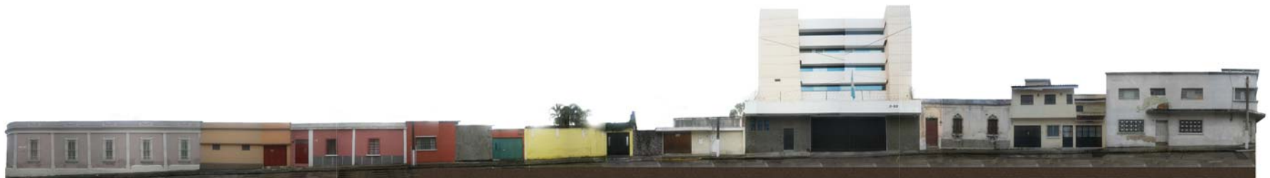
4 ESTADO ACTUAL DE FACHADA 6a AVENIDA A ENTRE 3A Y 4A CALLE ESTE
