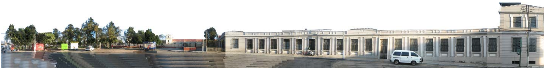
1 ESTADO ACTUAL DE FACHADA 3a CALLE ENTRE 6a Y 7a AVENIDA NORTE
