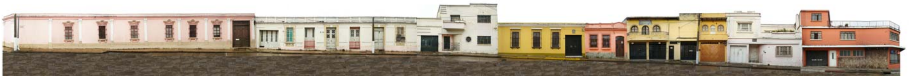
4 ESTADO ACTUAL DE FACHADA 6a AVENIDA A ENTRE 3A Y 4A CALLE OESTE
