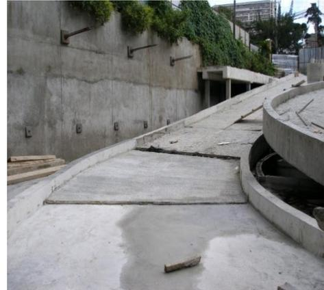
**Muros de concreto lanzado:** se aprecia la conformación de muros anclados a las paredes de la excavación, éstos han sido cuidadosamente desarrollados por capas desde su nivel inferior al superior.
