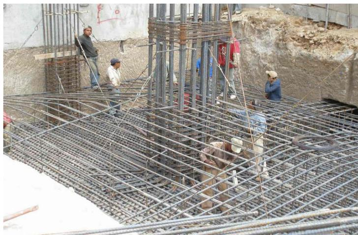
**Armado de zapata trapezoidal:** Se muestra el proceso de armado, donde se ve el pie de columna soportado en la primera cama de zapata, el armado de viga conectora y las columnas están en su posición.
