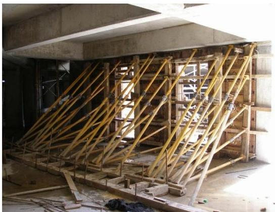
Se observa el uso de formaleta, puntales metálicos, y soportes con balules; para la fijación de entranquillado de muros de ductos de elevador, su base está muy bien reforzada.
