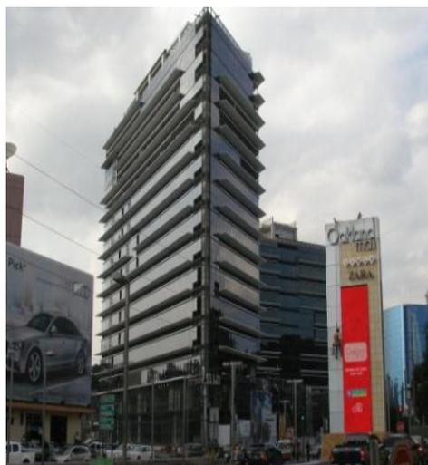
**Instalación del vidrio:** Se muestra la colocación de vidrios en forma parcial en las fachadas del Edificio. El orden de instalar lo designa el Arquitecto residente de la Empresa contratada, en éste caso fue ALUVER; algunas veces cambia el orden debido a que no ha llegado el vidrio importado. Se sellan los remates con silicón estructural color negro.
