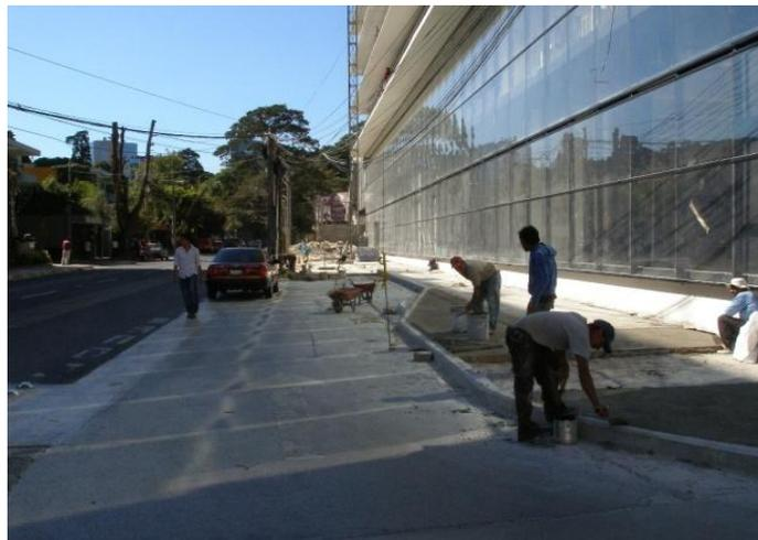
**Banquetas exteriores:** Se observa la terminación de banquetas, aplicándose el acabado en bordillos de calle.
