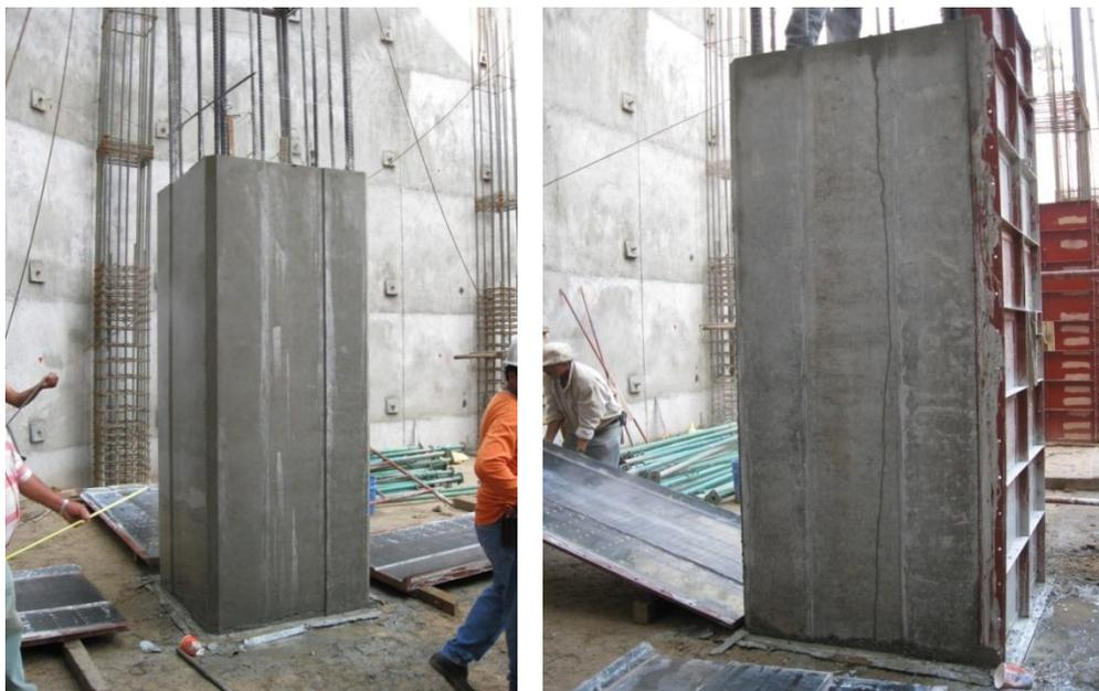
**Desencofrado de columnas:** La formaleta utilizada es metálica contiene agujeros para la fijación con tornillos, ya tiene incorporadas piezas metálicas que forman los ochavos en sus esquinas, las formaletas empleadas son muy pesadas se necesita emplear 4 personas para trasladarlas y levantarlas para hacer el encofrado.
