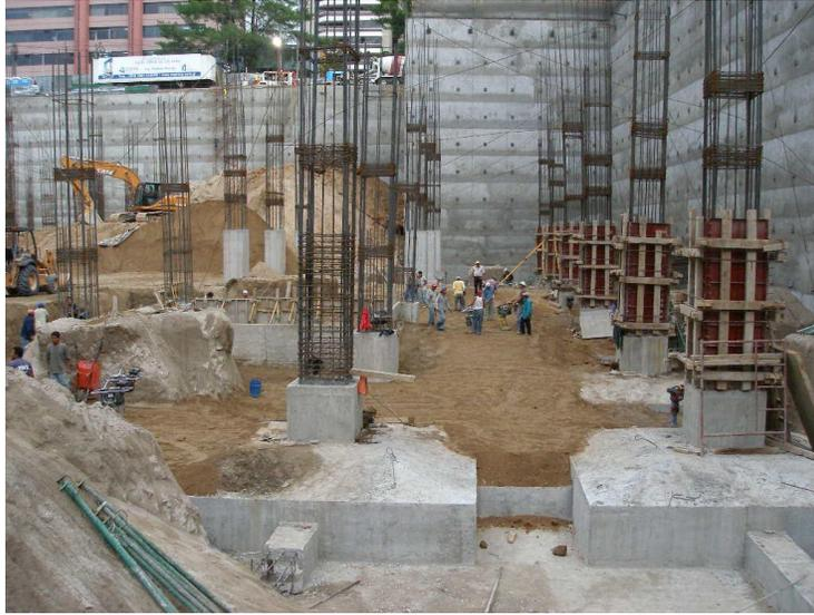
**Encofrado de columnas:** Se aprecia el avance del encajuelado para columnas, las formaletas han sido reforzadas previo a la fundición.
