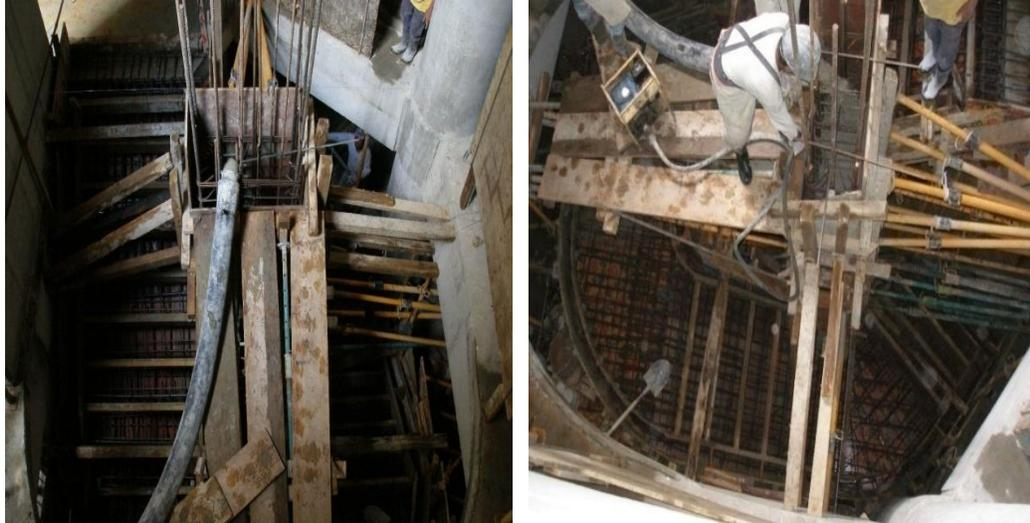
**Encofrado y fundición en gradas:** Se observa el tipo de encofrado, entranquillado para columna de anclaje de gradas circulares y el armado, para fundición monolítica.
