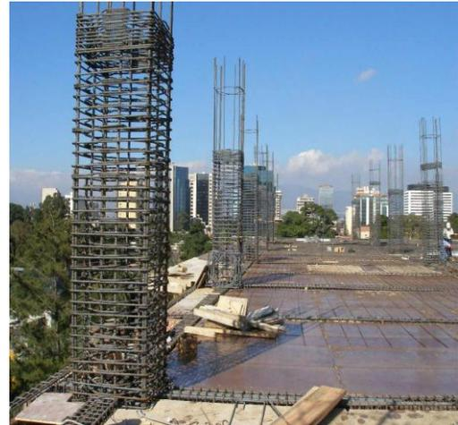
**Dinteledo para vigas:** Se observa terminado el colocado de puntales y dinteles.
