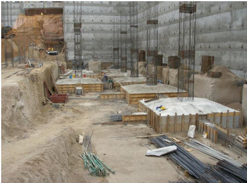
**Curado de zapatas:** las zapatas pueden ser rociadas con agua, o se les aplica anti sol, su secado es rápido y se facilita hacerlo porque lo permite el espacio a sus lados, se puede observar cerca de los muros que ya se tiene apilado armadura de estribos para columnas.
