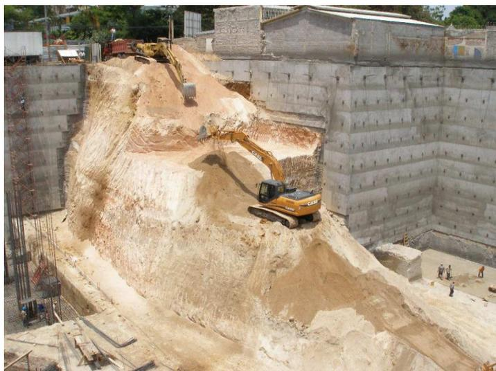
**Conformación de rampa de acceso:** Se observa a 2 excavadoras, haciendo el acceso con material selecto removiéndolo para lograr llegar al nivel inferior de un sótano 5.
