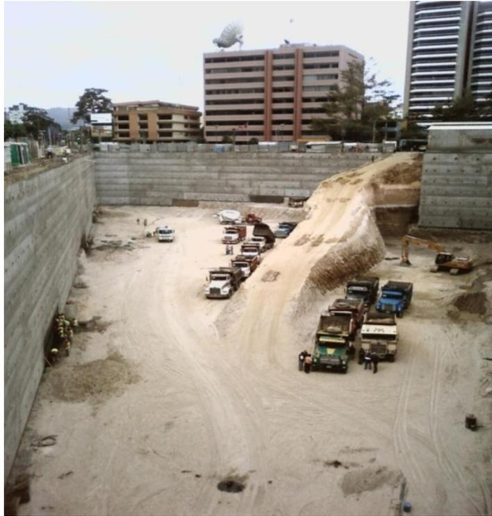
**Rampa de acceso terminada:** Se observa que ha sido conformada la plataforma de la rampa del acceso en el área de sótano.
