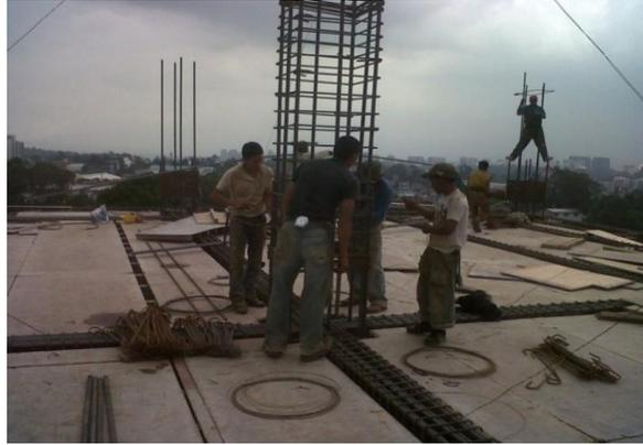
**Centrado y armado de columnas:** Se procede a bajar y amarrar los estribos, se centra revisando plomos y después de coloca la formaleta (encajuelado).
