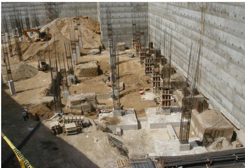
**Vigas conectoras de amarre:** Se aprecia la unión estructural entre zapatas haciendo uso de otro elemento estructural que son las vigas conectoras, también se observa el tipo de encajuelado para columnas usando formaleta metálica reforzada con madera.
