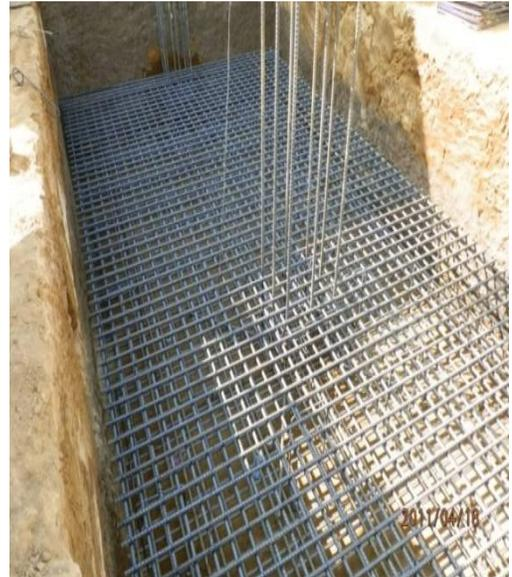
**Preparado de suelo para cimentación o zapatas:** Se puede observar que se ha terminado de conformar la excavación y se ha aplicado la base del topin con suelo cemento.
