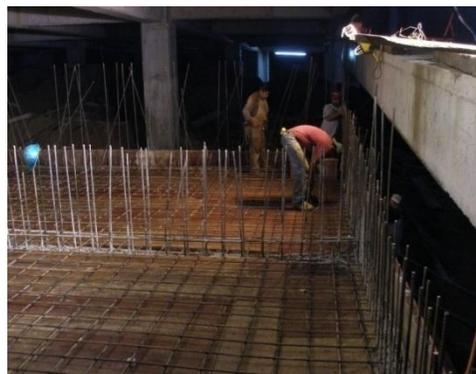
**Emplacado:** Foto izquierda se observa la colocación de balules para tranquilla y el armado en piso con declives, las esquinas o unión de muros están reforzados adicionalmente.
