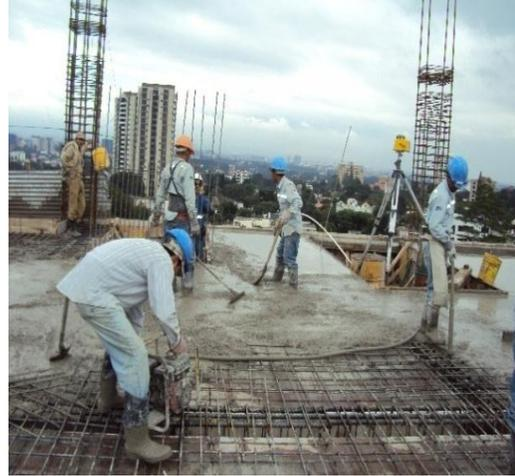
**Arrastres lisos:** Se deben colocar arrastres lisos para controlar el espesor de losa, y que no varíe mucho la cantidad solicitada.
