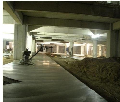
**Fundición de pisos en sótano:** Se observa la colocación de arrastres metálicos sujetados con pines y posterior a la fundición (6 horas después), se pasa el helicóptero para hacer el acabado final trabajo que lleva 8 horas para su aplicación total.
