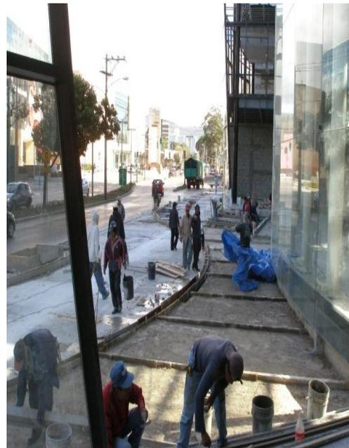
**Banquetas de esquina:** se observa el remate de fundición de banquetas siguiendo las líneas de proyección del edificio.
