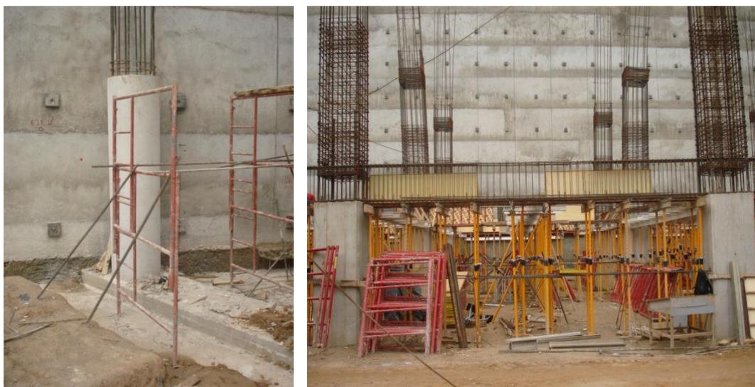
**Columnas de sección circular y cuadradas:** En la fotografía lado izquierdo se observa 1 columna circular fundida y desencofrada; al pie su viga conectora, la fotografía derecha muestra columnas cuadradas en proceso de dintelado de vigas, se aprecia el uso de doble puntal metálico.
