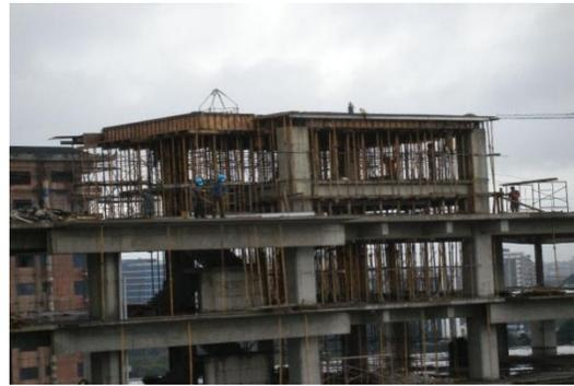
**Vista de losas acumuladas:** Se observan las losas fundidas y la torre de la Pluma radial instalada, también vista de tarima para losa final en cuarto de maquinas.
