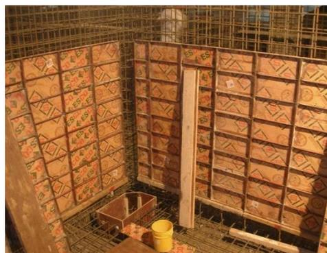
**Emplacado en muros:** Se modula la formaleta symoons para la colocación, los ajustes se harán con plywood fenolico y se hizo en forma vertical, el entranquillado será horizontal. Se observa el encofrado de la succión y el armado para piso es de 2 camas.
