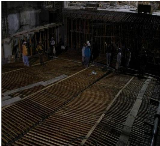
**Rampas de acceso lineales:** Se observa la tarima terminada, la cola de pescado formada para las gradas vibratorias, en la tarima se utilizó plywood fenolico y por debajo vigas de aluminio soportadas por puntales metálicos. Es el mismo proceso utilizado para todas las losas tradicionales planas de los diferentes niveles.
