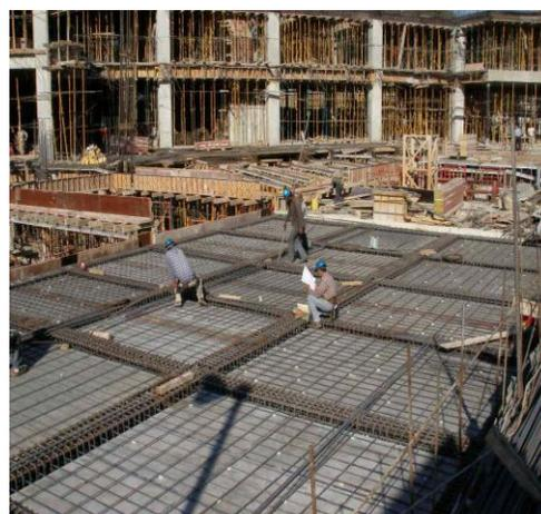
**Armado de losa tradicional:** Este tipo de losas son muy prácticas de elaborar, teniendo los grupos de armadores bien clasificados se logra un avance muy rápido, los armados de vigas son bien parecidos, Se observa que al fondo de ésta plaza ya existe losas fundidas.
