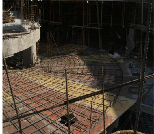
**Tarimas y armados para losas circulares:** Para las tarimas de este tipo de losas armadas, se utiliza también pliegos de plywood fenolico de 4x8pies x3/4", vigas de aluminio de 6" de peralte y largo variable según se necesite, y puntales metálicos, en la fotografía izquierda se muestra la armadura de muro de soporte que viene del piso anterior (sótano 1), anclaje que sirve para darle estabilidad a la losa.
