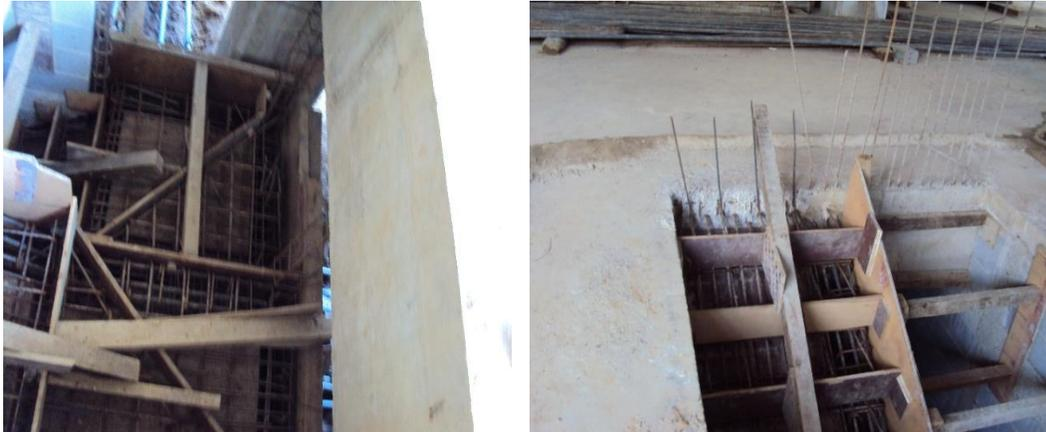
**Encofrado y armado de gradas:** En la fotografía izquierda se observa el encofrado para el descanso a 45 grados.
