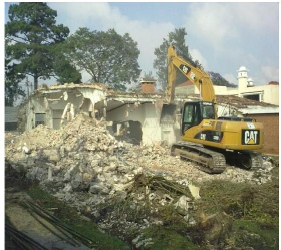
**Demolición directa:** La correcta posición de la máquina excavadora hace que sea más efectivo su trabajo a realizar.
