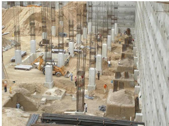
**Columnas fundidas:** En la fotografía inferior se observan grupo de columnas con troncos fundidos, las áreas de troncos de columnas ya fundidas se pueden compactar a los 4 días después.
