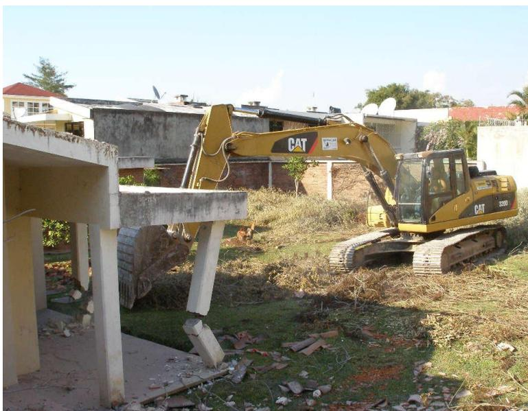
**Inicio de la demolición:** El residente verifica y dirige la forma en que necesita que se proceda con la demolición de las edificaciones encontradas, en el terreno contemplando el espacio disponible y necesario para el buen desempeño de la maquinaria a emplear.
