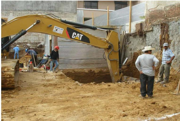
**Excavación para zapatas:** Se observa que se ha trazado previamente, y se ha iniciado la excavación para las zapatas. Es importante decidir el punto inicial del proceso para finalizar en un lugar que permita salir a la maquina excavadora.
