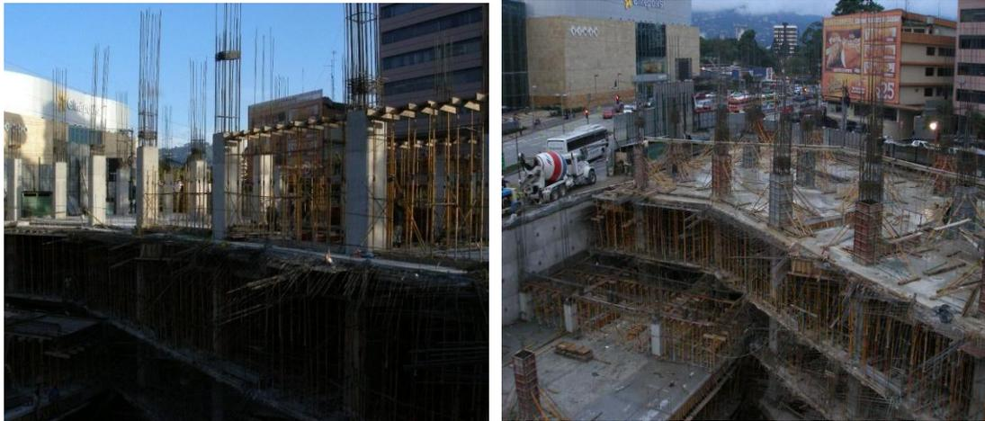
**Dinteleado para vigas:** En la fotografía izquierda se observa el proceso de dinteado después de haber fundido columnas.
