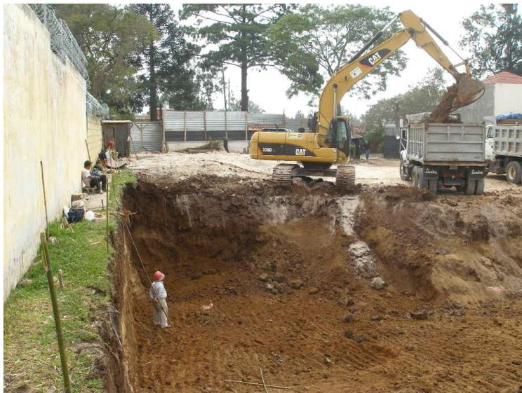
**Llenado de camiones:** La excavadora debe estar ubicada en posición correcta para el buen desempeño en el trabajo de excavación y llenado de camiones de volteo.
