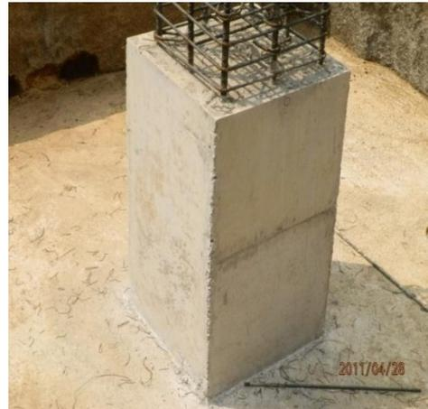
**Troncos de columnas:** En la fotografía del lado izquierdo se observa el tipo de encofrado. En la fotografía del lado derecho se puede observar el tronco de columna ya fundido y desencofrado; los estribos ya están colocados en su posición correcta, a los 4 días se puede compactar por capas de 0.20 mts.
