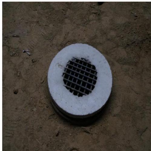
**Candelas y reposaderas:** Se observa el tipo de reposadera prefabricada para instalar sobre niveles de piso.
