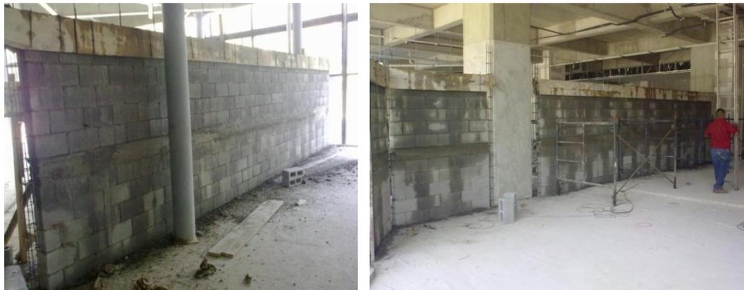
**Levantado de muros:** Para la ubicación correcta de muros en locales comerciales, es necesario haber verificado con trazo de topografía previamente contemplando las áreas de los mismos según información del Departamento de Diseño y administración.
