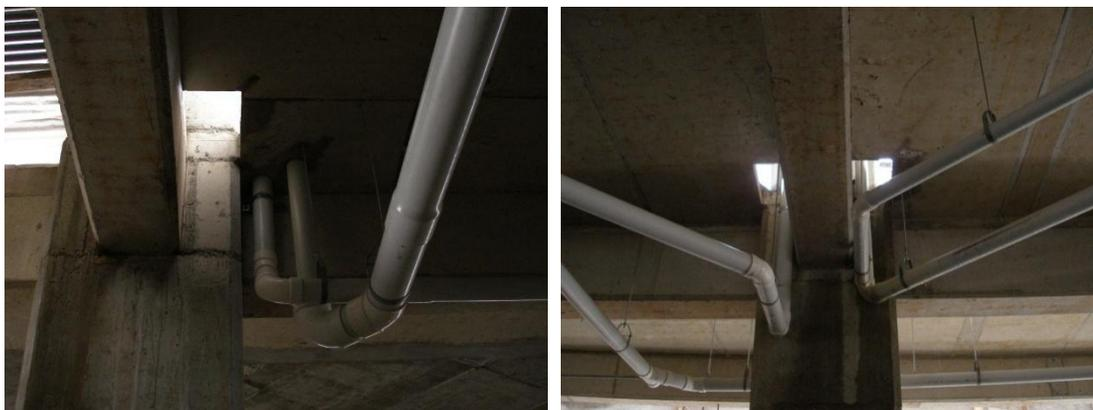
**Uso de ductos para instalaciones:** Se muestran 2 ejemplos de la ubicación correcta e incorrecta de ductos según planos, para continuidad de otros niveles.
