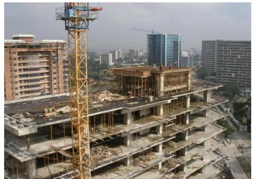
**Losa final:** Se observa el entarimado, faldoneado y el armado de la losa que albergará los equipos de ascensores.
