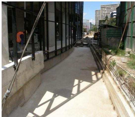
**Muleones en fachadas:** Se observa la fijación de muleones verticales y horizontales bajando del nivel de piso interior para un mejor remate en fachada. La fijación se hace usando tornillos tipo hilty expansivos empotrados con angulares al concreto.
