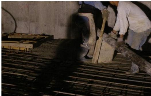
**Compuerta superior:** Se observa la formaleta instalada para el brocal de tapadera a nivel de losa, con el emparrillado listo.
