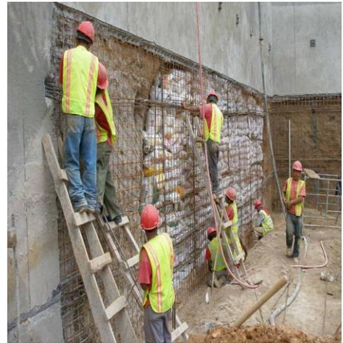
**Relleno:** Se procedió a hacer relleno en la cara del muro del corte, debido a derrumbe cuando se afinó el corte, y se utilizó material selecto embolsado para llenar.
