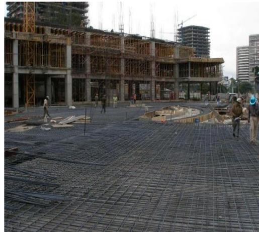
**Tarimas y armados:** Se puede apreciar en las diferentes fotografías las tarimas terminadas bien definidas en toda su área habiendo utilizado plywood tipo fenolico al cual se le aplicará desencofrante, también se observan diferentes armados sobre tarimas, esperas de empalme por continuidad en la fotografía inferior izquierda, doble cama de armado al lado derecho porque es un sector de PLAZA del edificio, “conformación de tarimas según planos estructurales bien definidos”.
