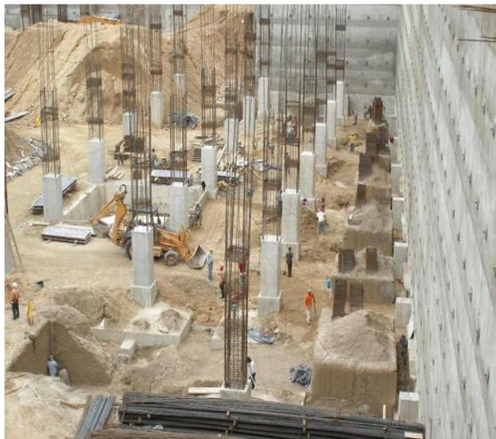
**Troncos y columnas:** se observa grupo de columnas fundidas y desencofradas en un área determinada en proceso de llenado de material selecto para posteriormente compactarlo por capas de 0.25 mts.
