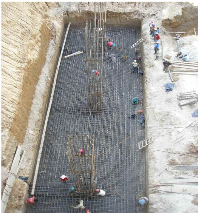
**Armado de zapata:** Se muestra el área de trabajo limpia y despejada, está conformado el armado de zapata, vigas conectoras y se está terminando el armado de columnas.
