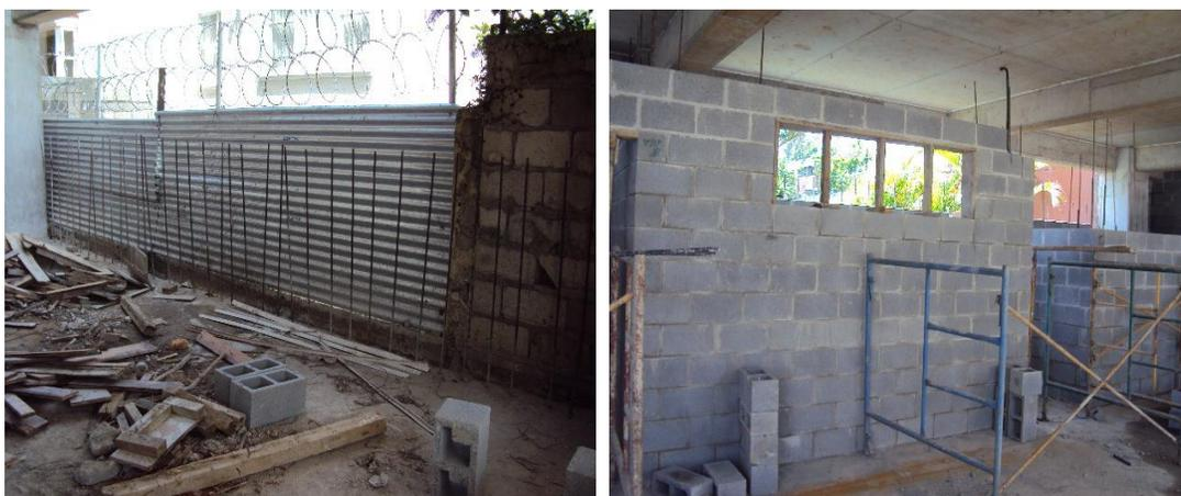
**Pineado:** la distribución de pines se hará de acuerdo a lo estipulado por el diseñador. Se observa el uso de andamios para realizar el proceso de levantado de muros.
