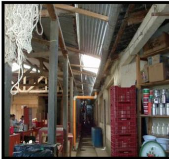
**Instalacion agua pluvial a simple vista, estructura en madera en mal estado.**
