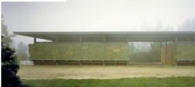
Los fardos son protegidos de la humedad del suelo al ser colocados sobre estanterías a lo largo de las fachadas a un metro de altura. Estas, ancladas a perfiles metálicos de las columnas del edificio.
