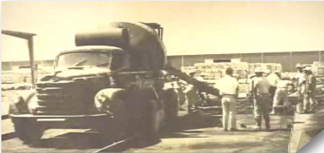
IMAGEN (FUNDICION DE BASES DEL MUELLE)
