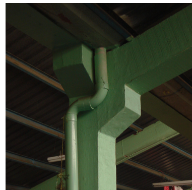
Foto No. 23. instalaciones Mayo de 2010
