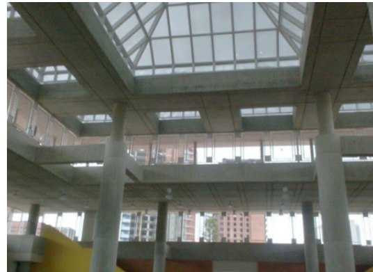
Foto No. 33 La cubierta de concreto reticulada que incluye las cúpulas de cristal, sostenidas con marcos rígidos de concreto. Se destaca la abertura que presenta hacia el exterior, lo que garantiza la iluminación. Mayo 2010
