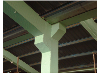
Foto No. 21. Estructura actual mayo del 2010
