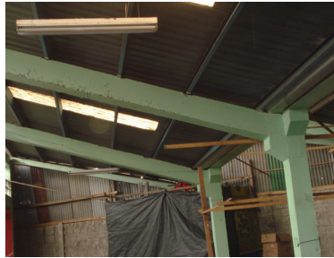
Foto No. 20. Estructura actual mayo del 2010
