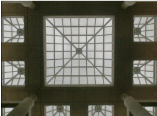
Foto No. 32 Las cúpulas de cristal sobre la plaza central proveen iluminación natural. Poseen una disposición reticular con módulos que se repiten en el contorno de una gran abertura en la parte central. Mayo 2010
