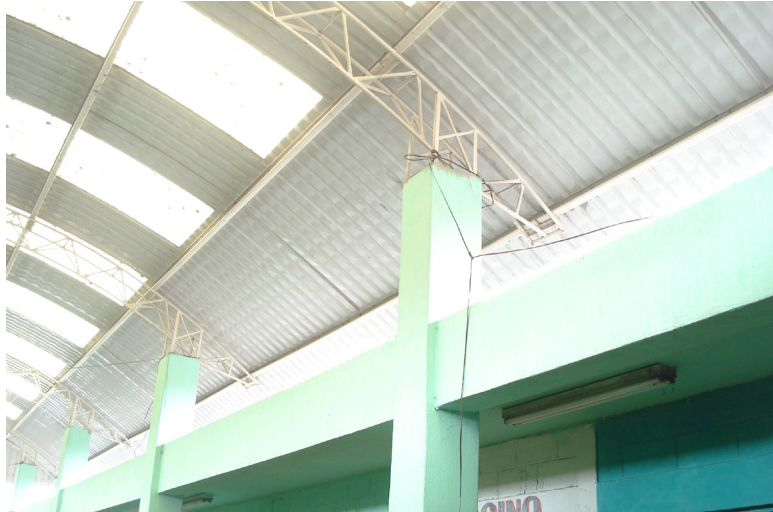
Foto No. 43. Detalle Estructural Mercado de San Lucas, Mayo de 2010
