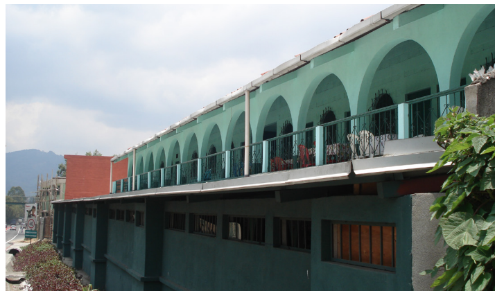
Foto No. 45. Fachada Sur, Mercado de San Lucas, Mayo de 2010
