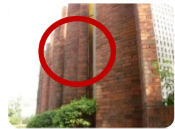
Foto 40: Alexis F. 2010 Muros con ángulos de 15 grados para evitar incidencia solar.
