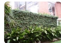
Foto 46: A. F. 2010 Muro cubierto con vegetación.
