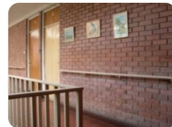
Foto 43: A. F. 2010 El material en la mayoría de las paredes es ladrillo visto.
