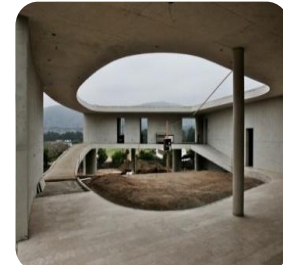
Foto 6: Google/images Arquitectura simple pero expresiva en aspecto formal
