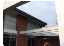
Foto 42: A. F. 2010 Vigas que sirve como elementos para rigidizar el edificio
