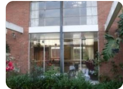
Foto 44: A. F. 2010 Combinación de vidrio, vigas de concreto y columna de acero, paredes de ladrillo.
