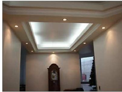
Ejemplo de cielos falsos decorativos en tablayeso o poliestileno, para el recubrimiento de las losas de entepiso del presente proyecto.
