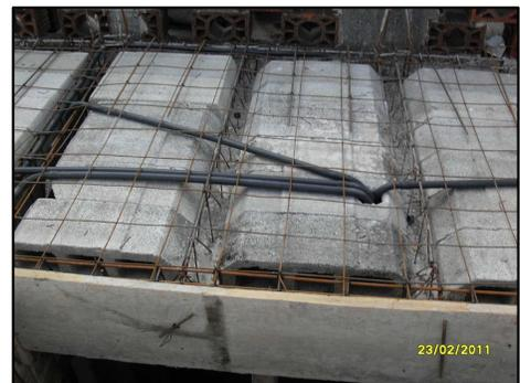
Una vez instalada la losa de vigueta y bovedilla, se debe colocar sobre la misma una MALLA ELECTROSOLDADA como refuerzo por temperatura para la fundición de concreto 2" que va sobre la misma.
