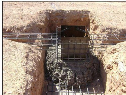
Fundición y amarre horizontal entre las columnas aisladas.
