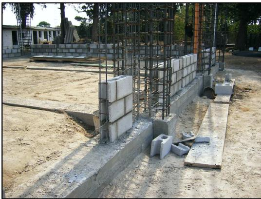
Pegado de block para el cerramiento vertical del edificio.
