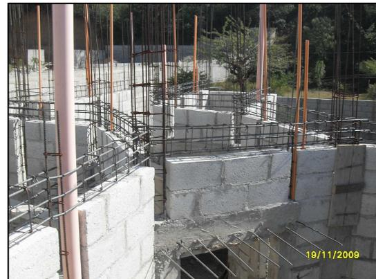
Todo muro debe rematarse en su parte superior con una solera de corona de concreto armado o con las vigas principales del marco estructural.
