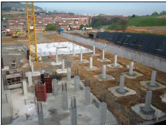
Columnas ya fundidas amarradas entre sí por medio de soleras de amarre enterradas y que conforman la parte vertical de los MARCOS ESTRUCTURALES del edificio.
