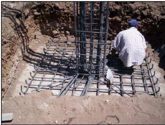
Armado de zapata y columna principal de estructura
