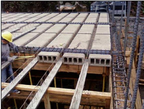
Forma correcta de la colocación e instalación de las viguetas y bovedillas. Las viguetas deberán reforzarse a cada 1.50m PERPENDICULARMENTE ENTRE SÍ, por medio de "RIGIDIZANTES" que son 2 varillas de hierro de  $\phi$  3/8" ó  $\phi$  1/2" + eslabón de  $\phi$  1/4" a cada 0.20m
