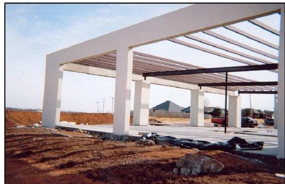
Ejemplo de vigas de concreto armado que además de amarrar las columnas en su parte superior, soportarán el peso de las LOSAS.
