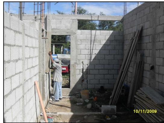
Muro de block, reforzado horizontalmente con block "U"
