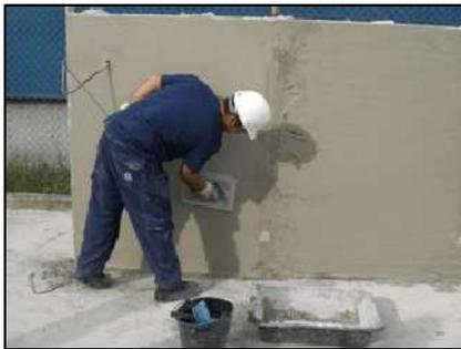
Aplicación de repello y texturizado DECOBLOK sobre muro de block
