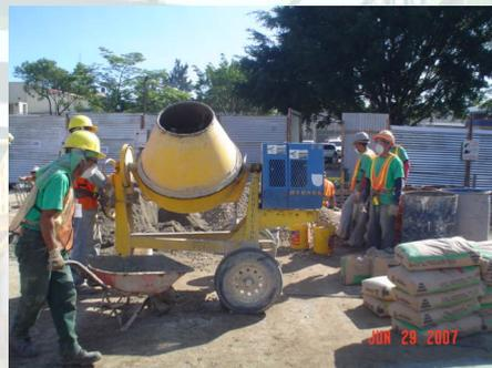
**3) Imagen:** Fundición de cimentación con Concretera, uso de mascarillas desechables, Fuente: Elaboración propia, supervisión de proyectos.
