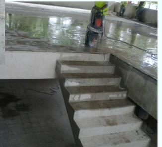
**2) Imágenes:** módulos de gradas sin señalización de doble altura, peligro de caída, Fuente: elaboración propia, visita a obra en construcción.
