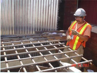
**29) Imagen:** Uso de Guantes de malla metálica, Armaduras de cimentación, Fuente: Elaboración propia, proyectos.
