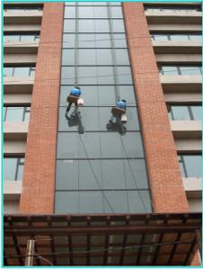
1) **Imagen:** Limpieza de muro cortina de edificio sin seguridad, Fuente: elaboración propia en supervisión de proyectos.
