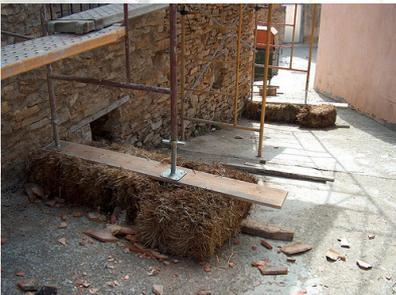
**20) Imagen:** Forma incorrecta del armado de un Andamio, (con tablonces como base y no esta nivelado), Fuente: Elaboración propia, proyectos.
