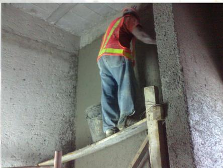
**25) Imagen:** Forma incorrecta de armado de un Andamio, Fuente: Elaboración propia.
