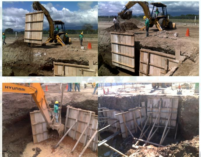
**Imagen No. 2:** Secuencia de imágenes de colocación paneles de tablonería para estabilizar área de excavación estructural de fosa de Tanques, Fuente: elaboración propia, proyectos.
