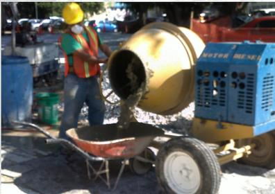
33) Imagen: mascarilla desechable para uso de concretera, vaciado de cemento en tolva, Fuente: Elaboración propia, proyectos.
