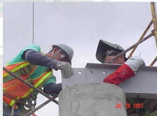
**22) Imagen:** Uso de Guantes para manipulación de estructura metálica, Fuente: elaboración propia, proyectos.
