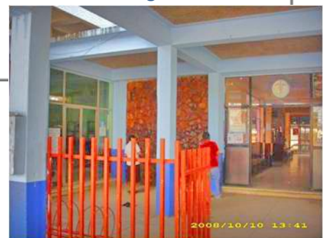
Ingreso Fuente: propia
