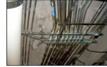
Foto No. 12 Instalaciones, H.P.Q.
