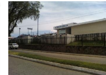
Foto No. 14 Fachada, H.P.Q
