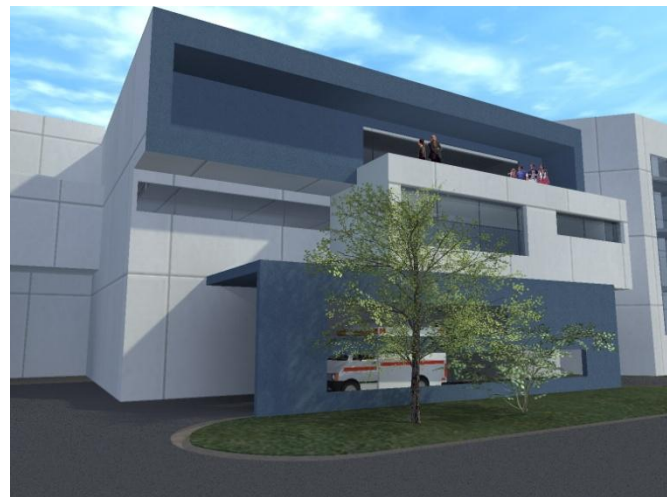
VISTA LATERAL - ESTE (EMERGENCIA)
