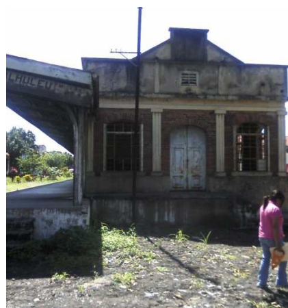
Fotografía 16 Antiguo Edificio Administrativo Fuente: Wilford Velásquez
