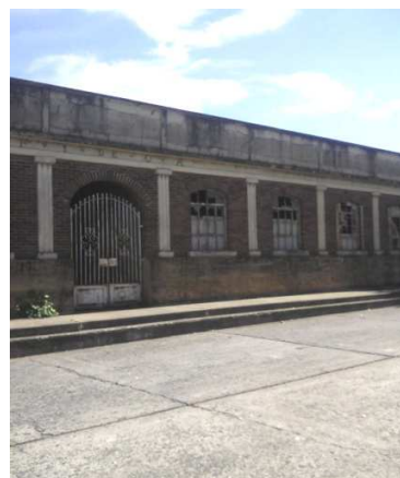
Fotografía 18 Antiguo Edificio Administrativo Fuente: Wilford Velásquez
