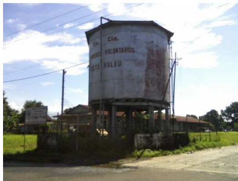
Fotografía 9 Tanque de agua existente Fuente: Wilford Velásquez
