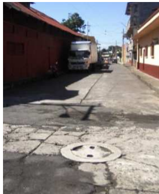
Ejemplo de pozo de visita existente para drenajes del sector
