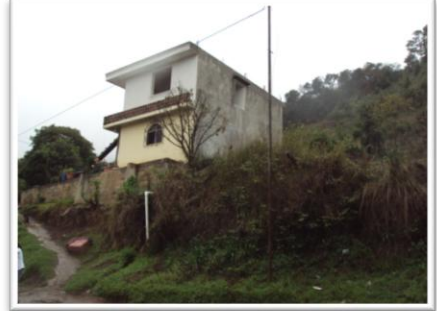
Imagen 17 Tubería del sector
