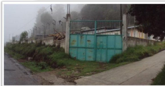
Imagen 21 Vista de muro y portón
