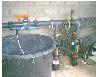
Imagen 366 Dosificador Venturi Imagen 367
