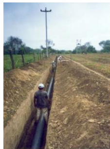
Imagen 349 Colocación de tubería principal en parcela
