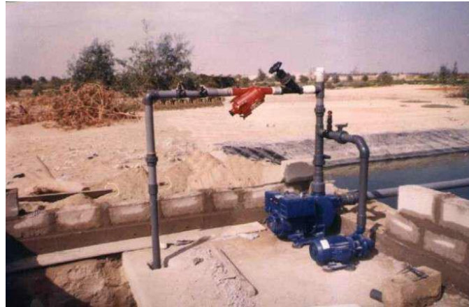
Imagen 343 Motor Eléctrico y de Combustión Acoplado a Bomba (La Yarada)
