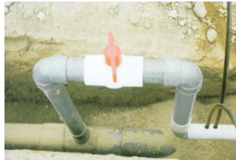
Imagen 352 Arco de riego secundario útil para la distribución de la tubería que abastece a los bigotes Fuente: Ing. José Pinto Villanueva. --Ing. Itay Pinto.
