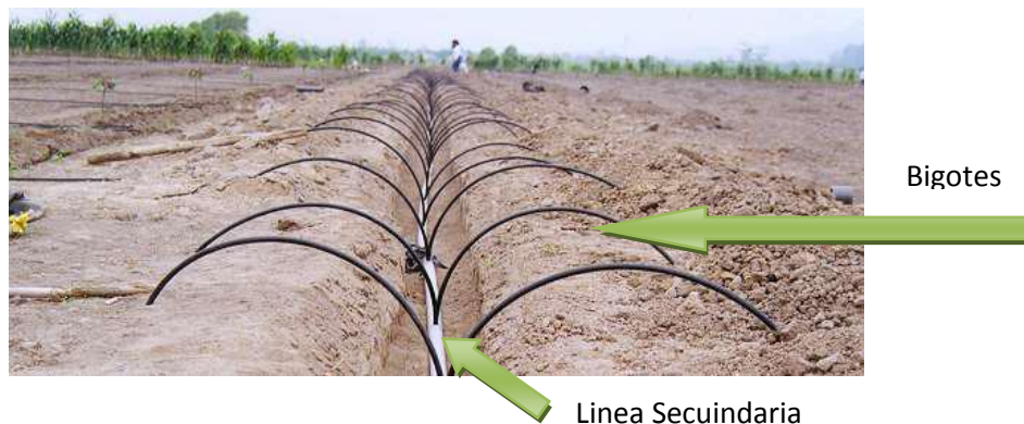
Imagen 357 Colocación de tubería secundarial en parcela
