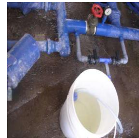
Imagen 366 Dosificador Venturi Imagen 367
