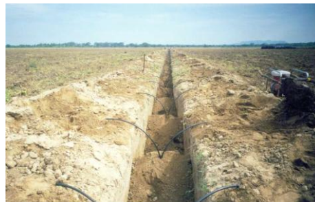
Imagen 358 Enterrado de tubería secundaria
