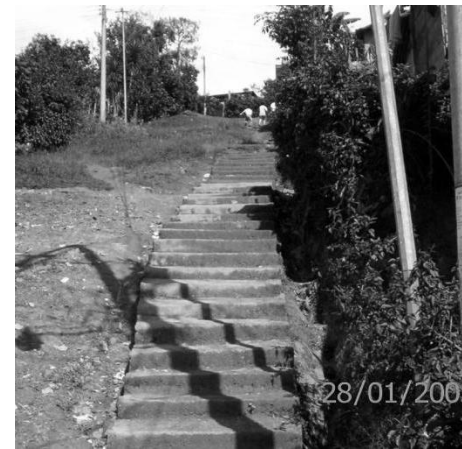
6ª, calle norte, peatonal EL ESFUERZO 1 FOTOGRAFÍA No. 13
