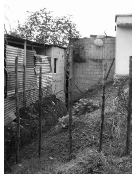
6ª, avenida B, sur, zanja de captación de agua pluvial, EL ESFUERZO 1 FOTOGRAFÍA No. 17
