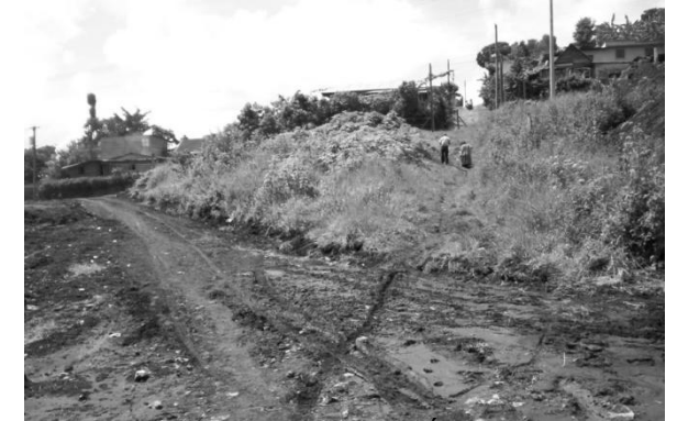
5ª, avenida, y 4ª calle intersección AREA VERDE EL ESFUERZO 1 FOTOGRAFÍA No. 26
