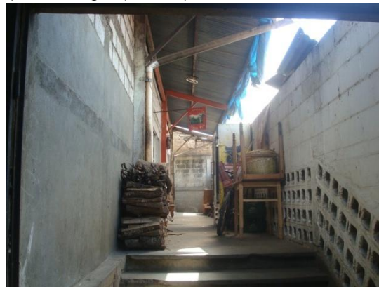
Foto 20 se observa el estado actual interno del área de carnicerías sin repello ni cernido.
