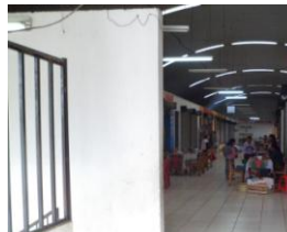
Foto 33: Segundo nivel Interior mercado área de Comedores y tiendas, Techado curvo.
