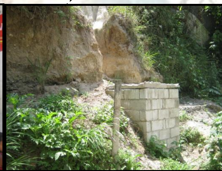
Imagen 2: Afuera del terreno se encuentra una caja registro, que lleva los residuos de aguas pluviales y negras del mismo. Fotografía del autor, 2010
