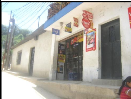
Imagen 3: Las construcciones aledañas se caracterizan por el uso de una puerta en su derecha y una abertura en su izquierda, ya sea como una entrada o ventana. Fotografía del autor, 2010
