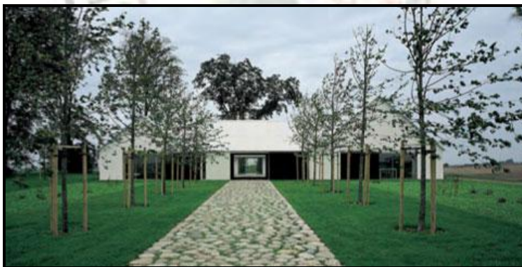
Encauzamiento hacia la entrada principal a través del cambio de textura en el camino. Sencillez y geometría elemental rectilínea en la fachada, así como ritmo en los elementos de la misma.
