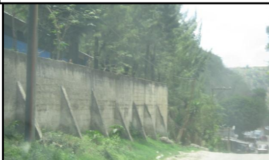
Imagen 5: Durante todo el camino hacia el terreno, se observa la escasa infraestructura, así también la mala calidad de las vías. Fotografía del autor, 2010
