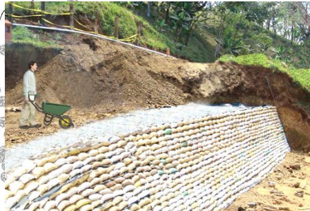
Taludes con Geobolsas para reforzar y proteger el talud con la erosión. Soluciones Especiales. Para el medio ambiente. www.google.com
