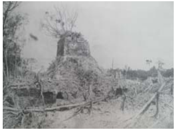
Vista del edificio V, Nakum
