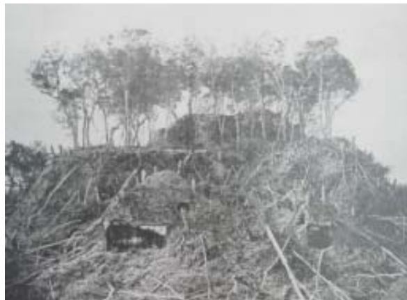
Vista panorámica de la Acrópolis Interior, Nakum.
