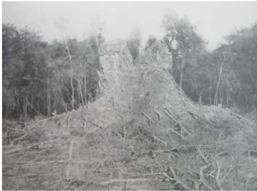
Vista Frontal del edificio V , Ciudad de Nakum
