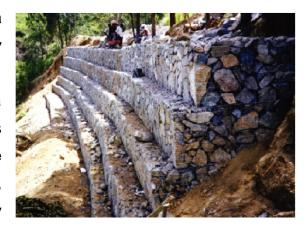
rellenados con piedras o rocas en el mismo sitio, con el fin de formar estructuras monolíticas, permeables, flexibles tales como muros de contención, malecones, recubrimientos de canales, revestimiento de taludes y vertederos, etc. Utilizadas para el control de erosión e inundaciones.
