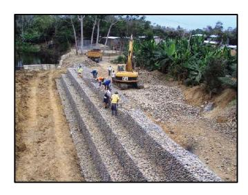
EL RELLENO ESTRUCTURAL DEBERÁ SER CONSTITUIDO POR SUELO DE BUENA CALIDAD (GRANULAR Y BIEN SELECCIONADO), CON ÁNGULO DE FRICCIÓN Y PERMEABILIDAD ELEVADOS, Y SOBRE TODO QUE MANTENGA SUS CARACTERÍSTICAS A LO LARGO DEL TIEMPO.
