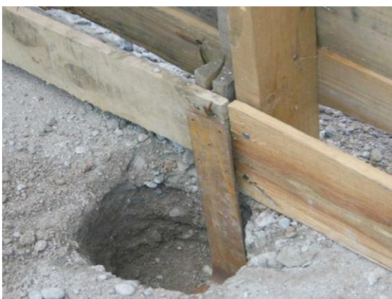
ANCLAJE DE TARIMAS AL PISO
