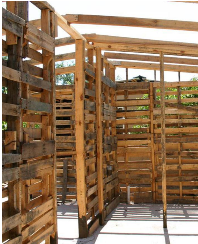
FORMA DE ARMADO DE TARIMAS INTERNAS
