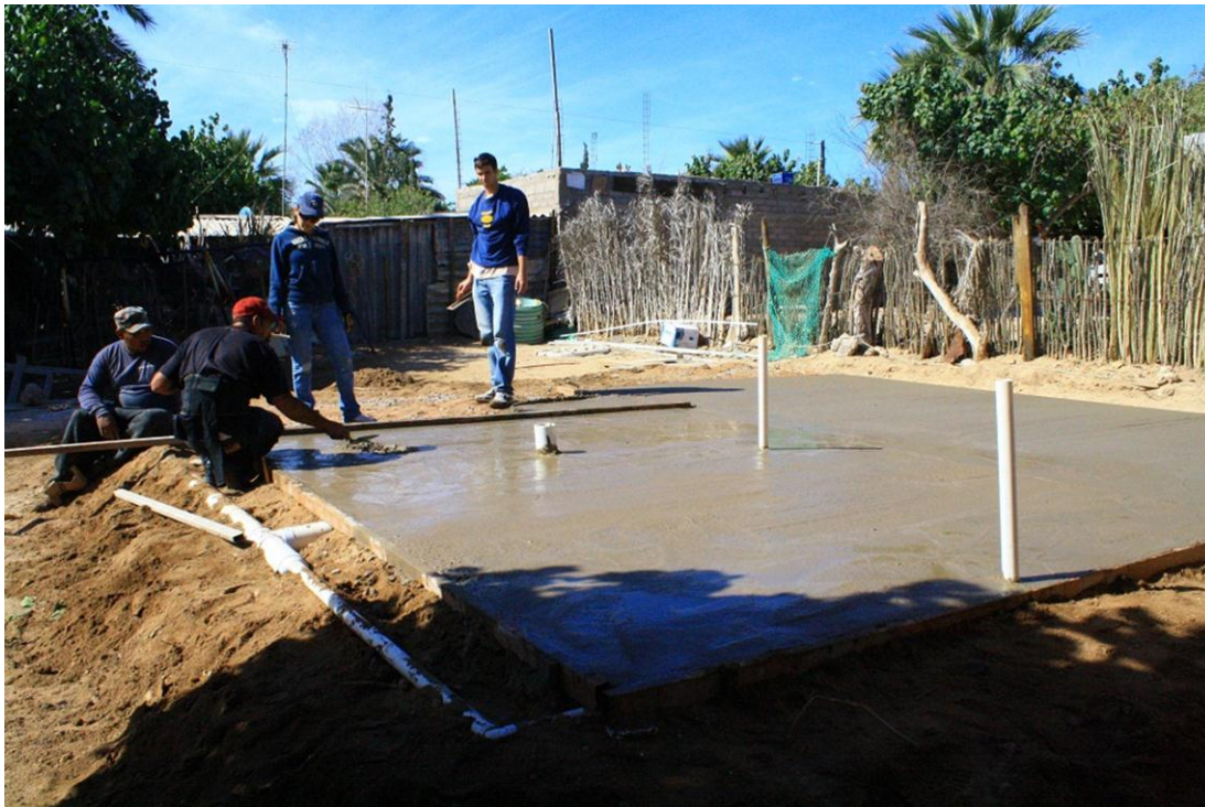
Fotografía indicando forma de cimentación de la vivienda
