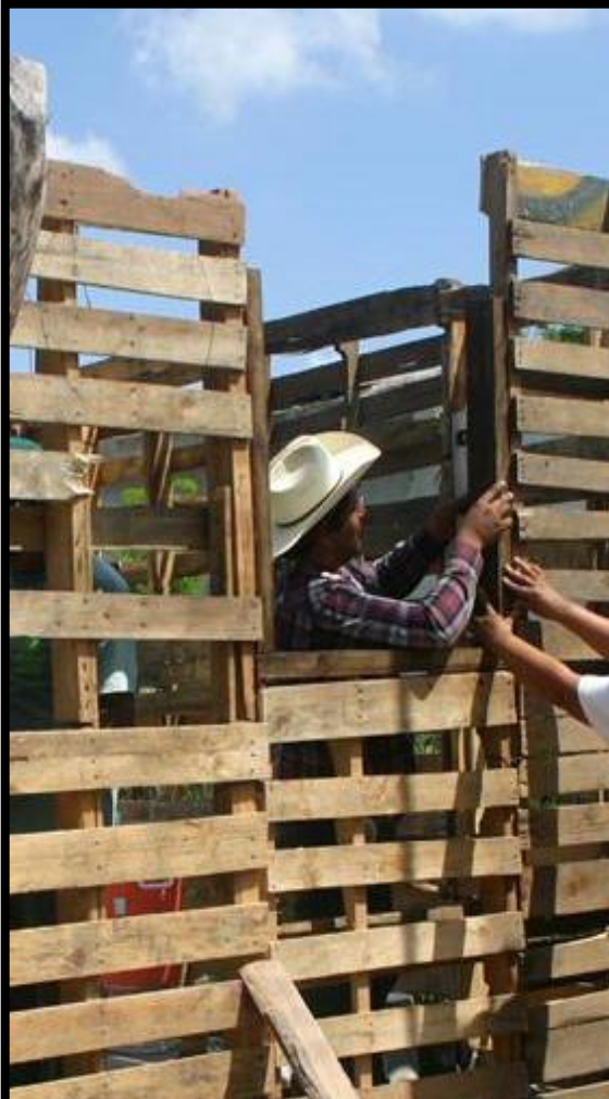
FORMA DE ARMADO VANO DE VENTANA
