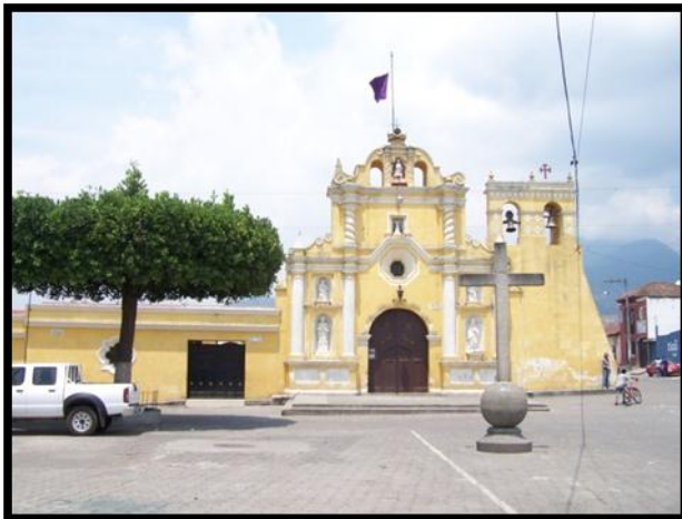
Fotografía 6: Templo de San Miguel Escobar (siglo XVII) construido en el valle de Almolonga, precisamente en el solar en donde el Lic. Francisco Marroquín, primer obispo de Guatemala, mandara construir la iglesia de Veracruz el 9 de marzo de 1533 y que en 1543 se le diera el nombre de San Miguel que conserva hasta nuestros días.
