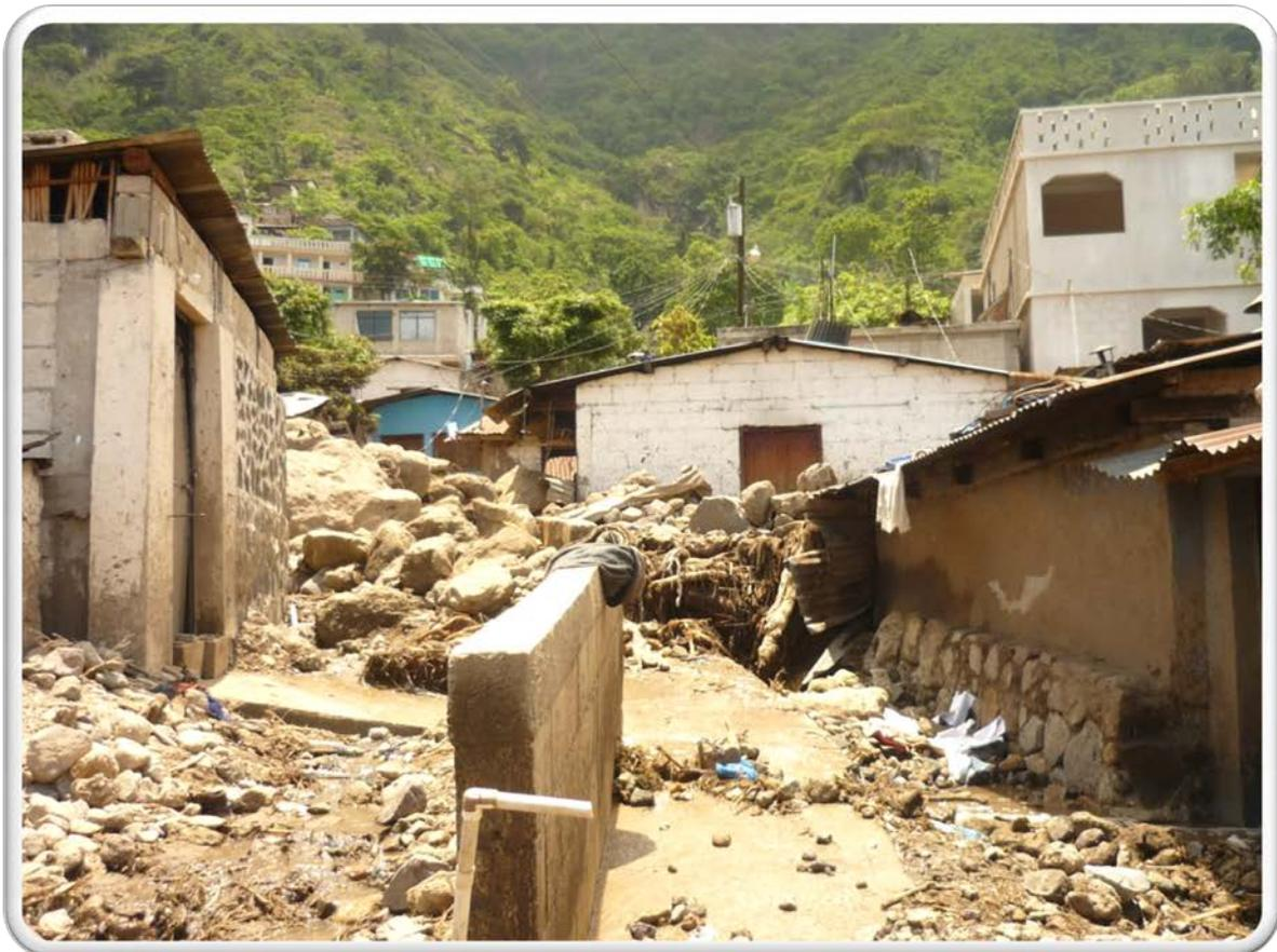
FOTOGRAFÍA 6.4. EL CENTRO URBANO ES UNA DE LAS ÁREAS AFECTADAS POR DESLIZAMIENTOS, COMO SE PUEDE OBSERVAR EN LA FOTOGRAFÍA EL PASO DE LA TORMENTA AGATHA TRAJÓ CONSIGO UNA SERIE DE DESLIZAMIENTOS QUE AFECTARON CONSIDERABLEMENTE AL POBLADO. FUENTE IMAGEN: VIVAMOS MEJOR.
