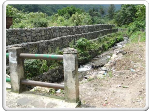
FOTOGRAFÍA No. 7.5. MUNICIPIO COMO SAN MARCOS LA LAGUNA SE VIO AFECTADO POR DIVERSOS DESLIZAMIENTOS DE ROCAS, LAS CUALES POSTERIORMENTE FUERON UTILIZADAS PARA DIFERENTES OBRAS DE INFRAESTRUCTURA COMO LOS GABIONES. FUENTE IMAGEN: GAMALIEL MARTÍNEZ M..
