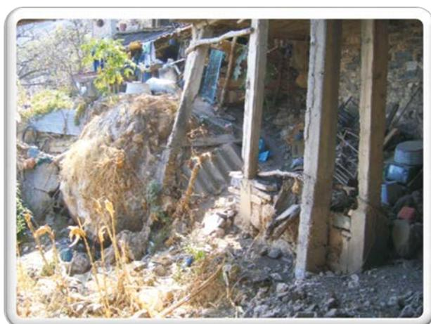
FOTOGRAFÍA No. 2.8. DESPRENDIMIENTO DE MATERIAL ROCOSO DE HASTA 36 METROS CUBICOS SOBRE LAS VIVIENDAS A CAUSA DE LA INESTABILIDAD DE LA LADERA.
