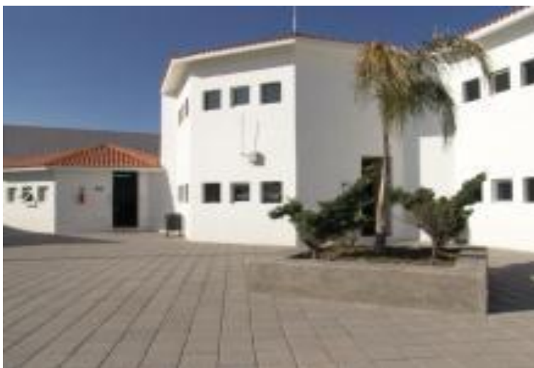
Fotografía No. 4 Área de Aulas, Universidad del Fútbol y Ciencias del Deporte
