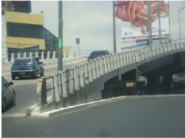
Fotografía No. 11 Puente de conexión entre carretera interamericana CA-1 y Ciudad San Cristóbal.
