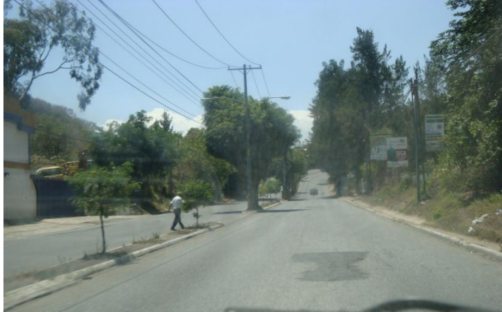
Fotografía No. 15 Ruta de Acceso al Terreno
