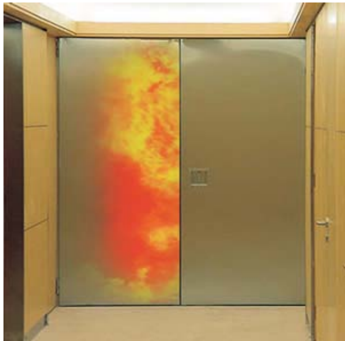
Ilustración 407, el uso de puertas resistentes al fuego, garantiza que los módulos de gradas no se convertirán en puntos vulnerables de propagación de humo y gases
