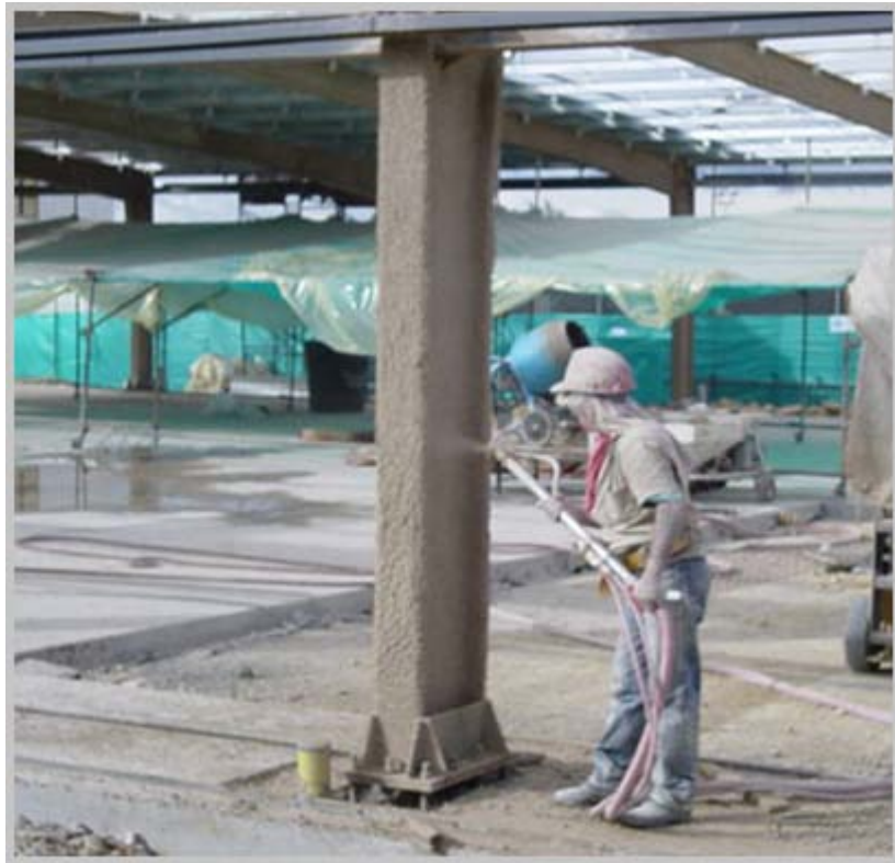
Ilustración 276, aplicación de recubrimiento intumescente a columna WF de acero estructural
