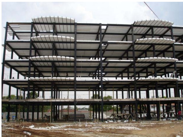
Ilustración 123, losa prefabricada con bovedillas de Poliestireno Expandido
