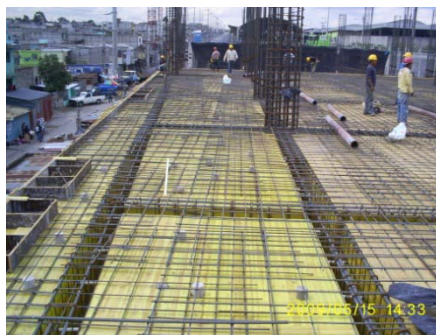
Ilustración 312, armado de losa tradicional
