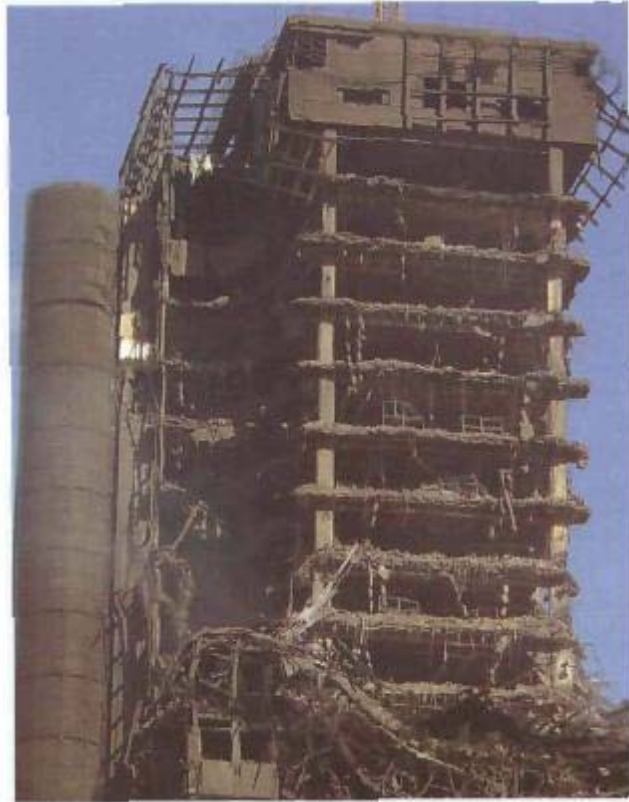
Ilustración 31, Incendio en edificio Windsor, Madrid, España
