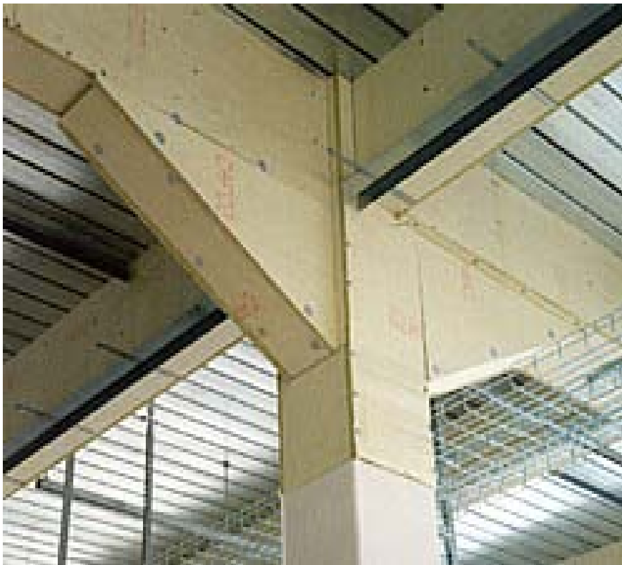
Ilustración 305, protección con paneles en estructuras de acero
