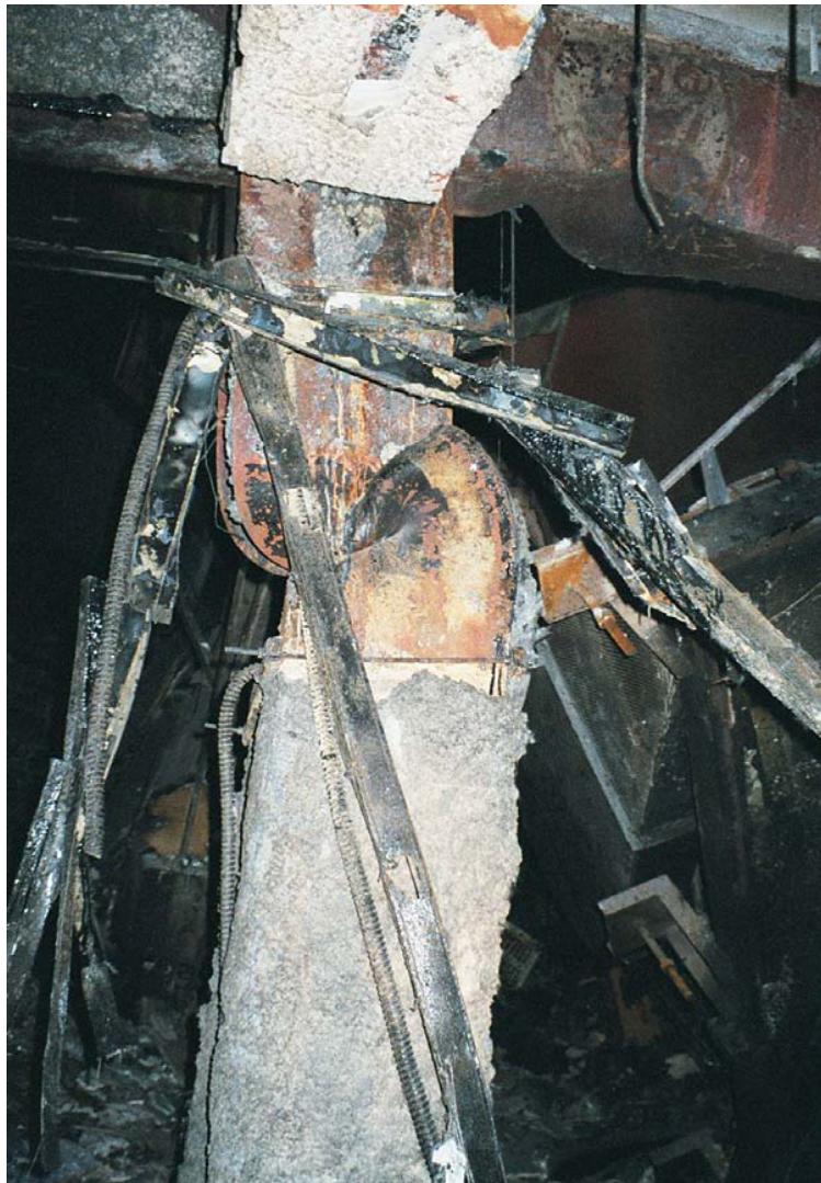
Ilustración 90, fallas por pandeo y aplastamiento en perfiles tubulares y en secciones solidas tipo WF
