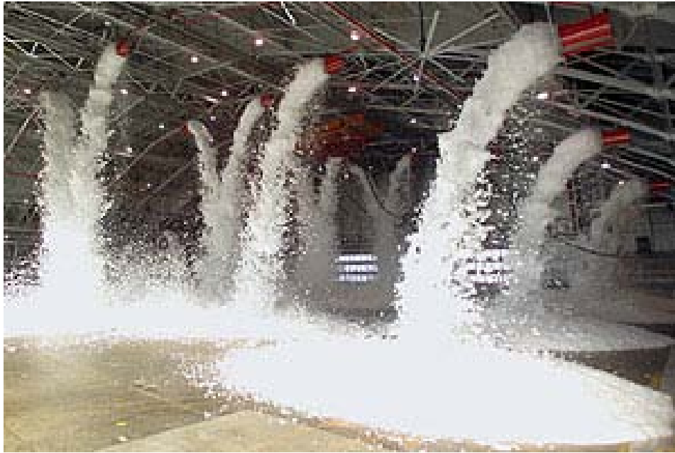
Ilustración 210, descarga de espuma de mediana expansión producida por un sistema de lanzas
