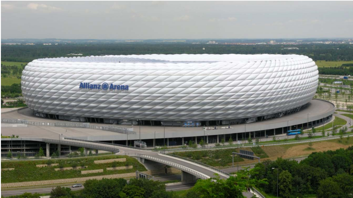
Ilustración 114, Estado Allianz Arena, Alemania. La membrana esta hecha a base de polímeros y llena de gas, que puede cambiar de color dependiendo de la estación y temporada
