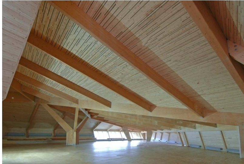
Ilustración 97, estructura de madera de vigas macizas
