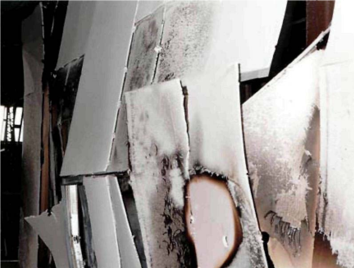
Ilustración 331, ensayo de resistencia en escala real, realizado en Inglaterra, muestra los efectos del fuego en un espacio compartimentado, en esta fotografía se observa la cara expuesta al efecto del fuego. El muro fue hecho a base de paneles de yeso, el ensayo fue efectuado en muros diseñados para 30 minutos de tiempo de exposición. Imagen obtenida de The integrity of compartmentation in buildings during a fire , Building Research Establishment, edición 2005.
