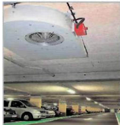
Ilustración 381, equipo de extracción electromecánico para azoteas y para sótanos
