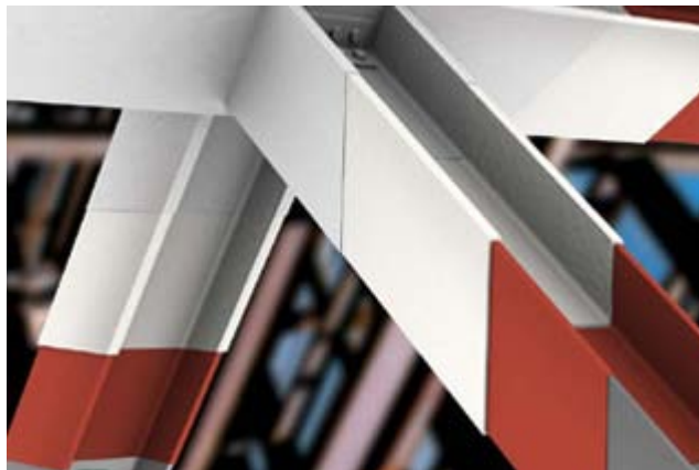
Ilustración 280, Estructura de acero de perfil WF con recubrimiento de pintura intumescente
