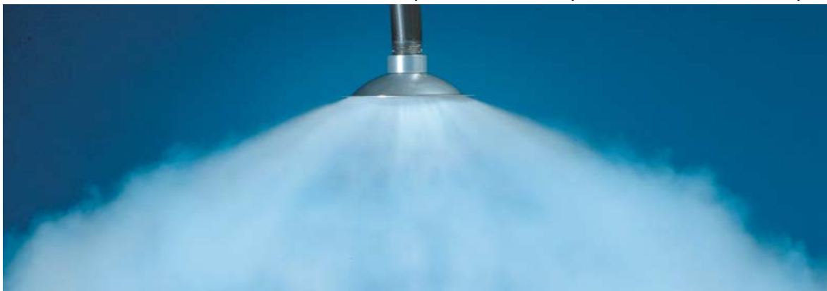
Ilustración 223, apariencia de una nube de descarga de \text{CO}_2 , efecto visual por descompresión del gas y cambio de temperatura al contacto con la temperatura ambiente
