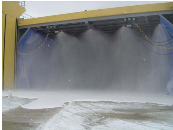
Ilustración 199, sistema de espuma de baja expansión
