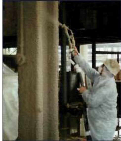
Ilustración 287, aplicación de mortero proyectado a columna de acero estructural
