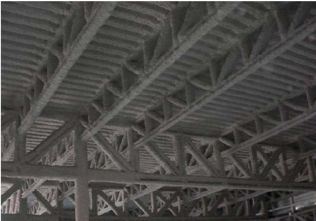
Ilustración 296, armaduras de estructura de techo recubierta por mortero proyectado
