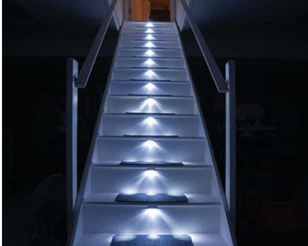
Ilustración 410, iluminación por leds para contrahuellas
