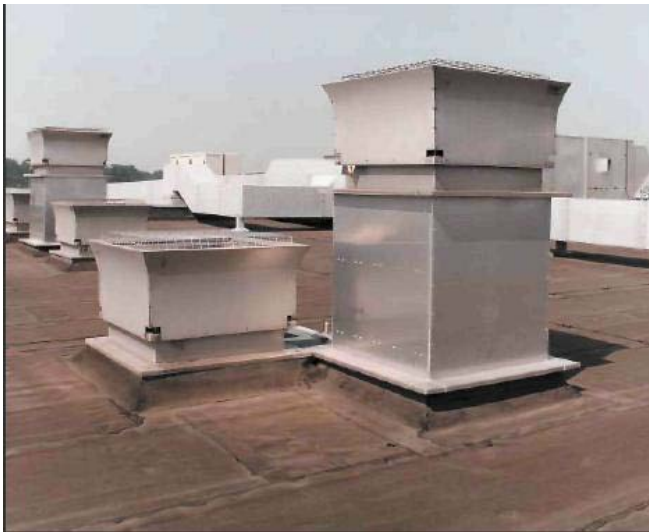
Ilustración 381, equipo de extracción electromecánico para azoteas y para sótanos
