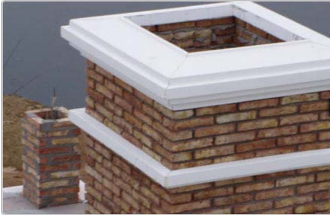
Ilustración 125, molduras en remate de chimeneas
