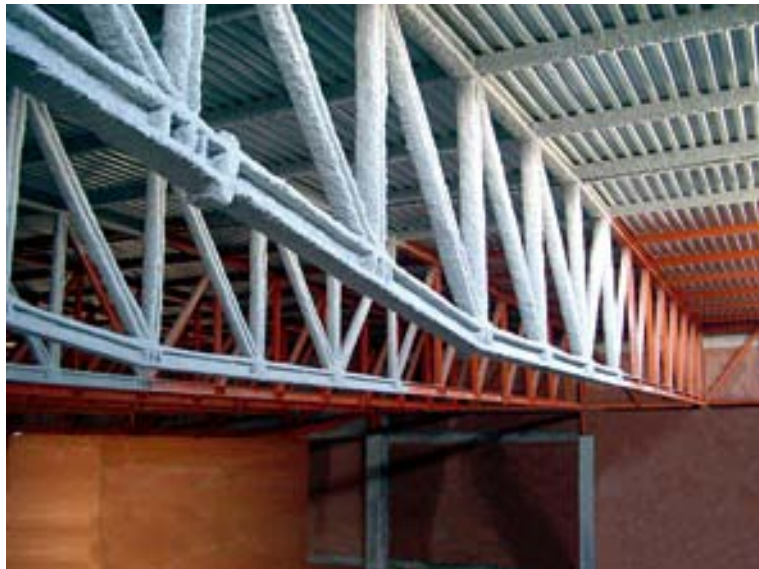
Ilustración 282, armaduras para soporte de cubiertas, protegidas con aplicación de recubrimiento intumescente
