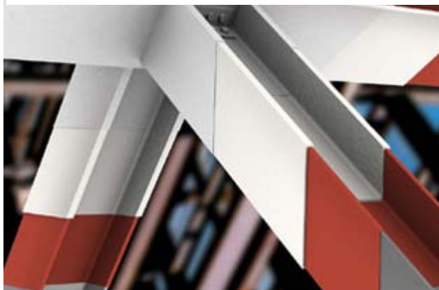
Ilustración 269, protección con pintura intumescente
