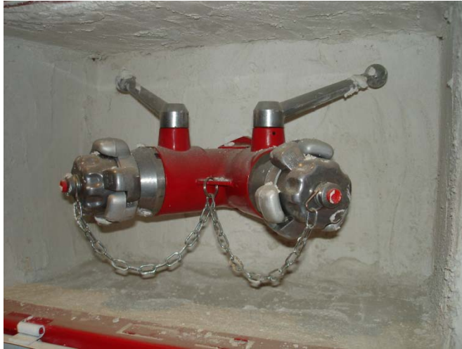
Ilustración 173, toma de columna seca por nivel, en descanso de gradas
