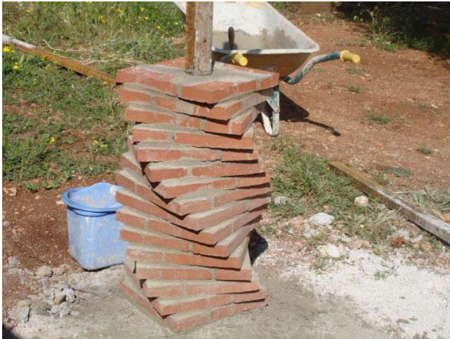
Ilustración 320, construcción de columnas de mampostería de arcilla
