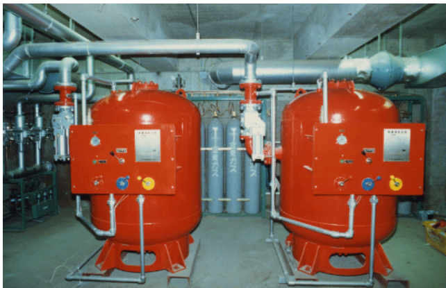
Ilustración 261, Contenedores para Polvo Químico Seco sin agente presurizador
