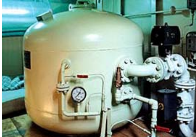
Ilustración 259, Contenedor de Polvo Químico Seco con agente presurizador
