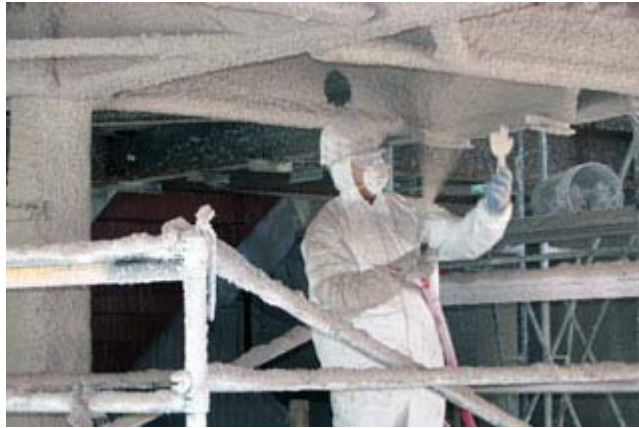
Ilustración 267, recubrimiento con mortero proyectado
