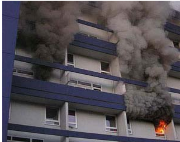
Ilustración 347, humo de combustión por incendio
