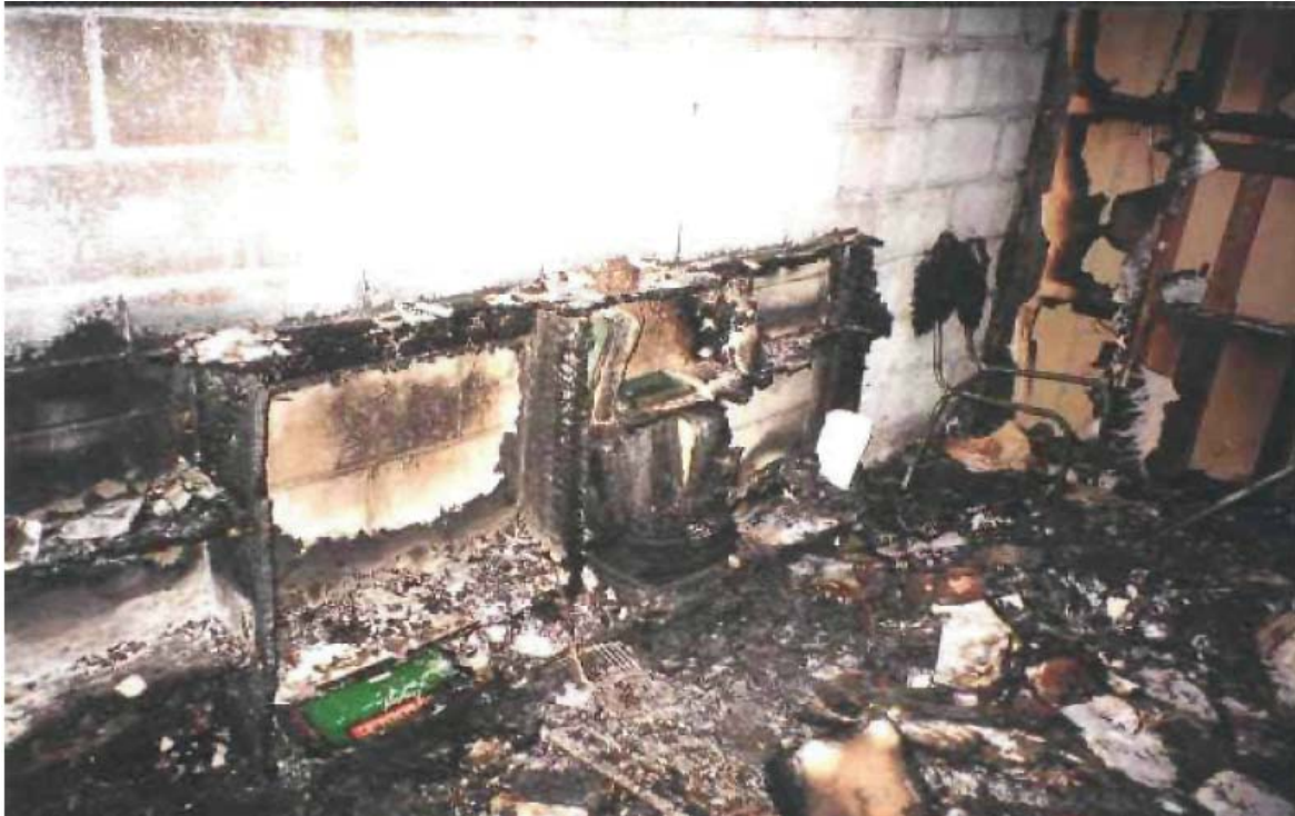
Ilustración 139, material combustible consumido parcialmente por las llamas, en un ensayo controlado, Fuente: NIST
