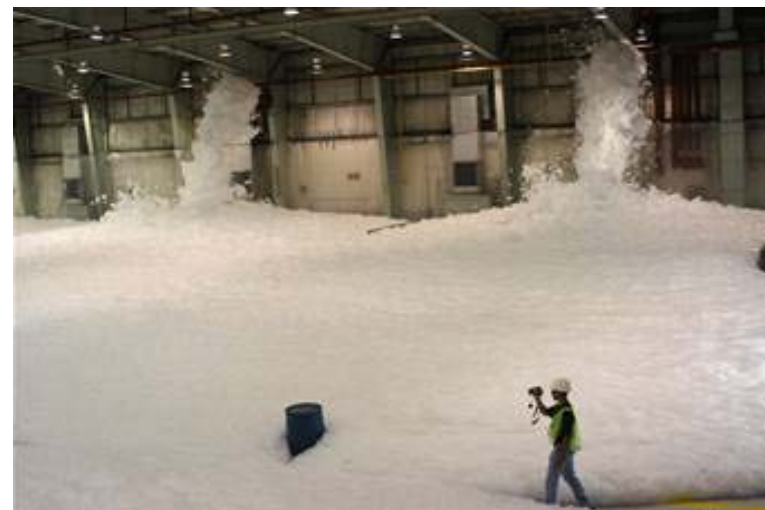
Ilustración 200, sistema de espuma de mediana expansión
