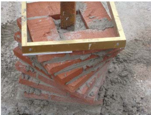
Ilustración 320, construcción de columnas de mampostería de arcilla
