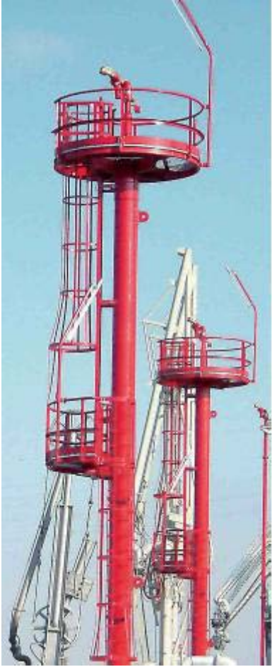
Ilustración 214, monitor en plataforma elevada
