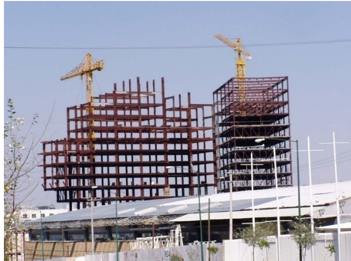
Ilustración 61, sistema constructivo de acero estructural
