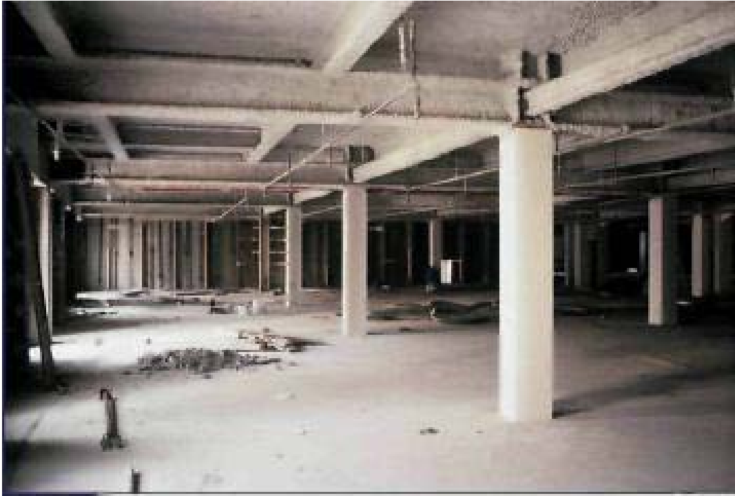
Ilustración 295, recubrimiento de mortero proyectado en estructuras de acero usadas como columnas
