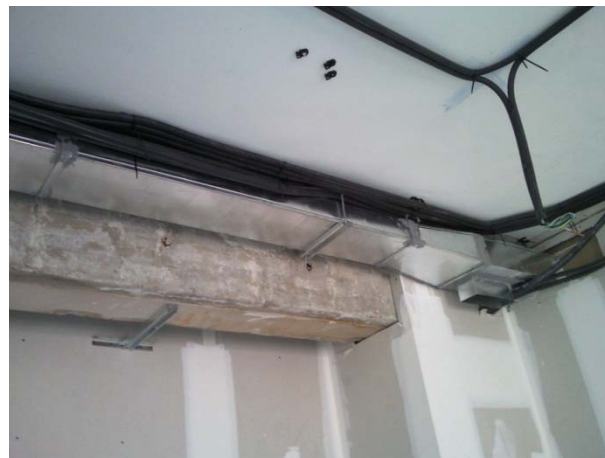
Ilustración 308, aislamiento de ductos de instalaciones
