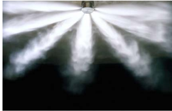
Ilustración 256, Descarga de agente halogenado
