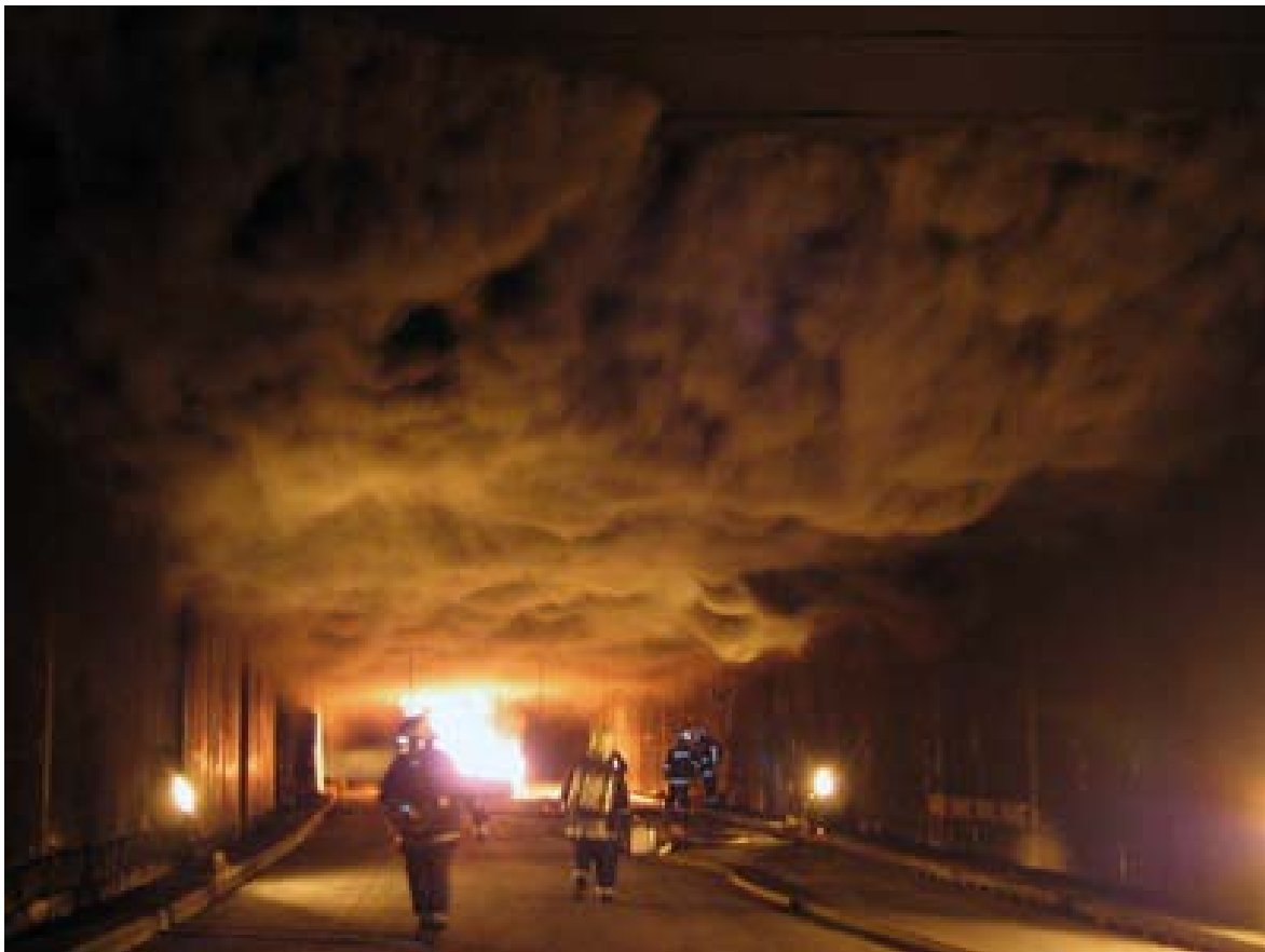
Ilustración 326, colchón de humo de combustión en incendio
