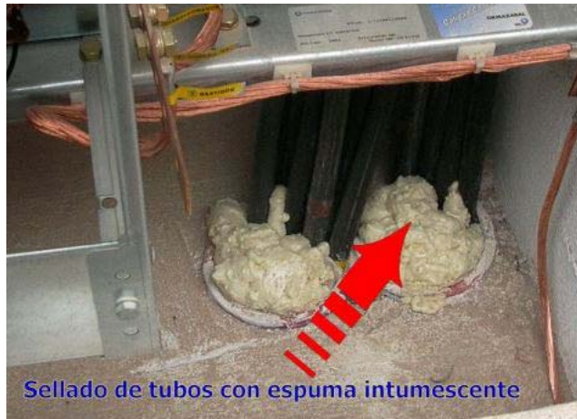
Ilustración 155, sello de tubos con espumas intumescentes
