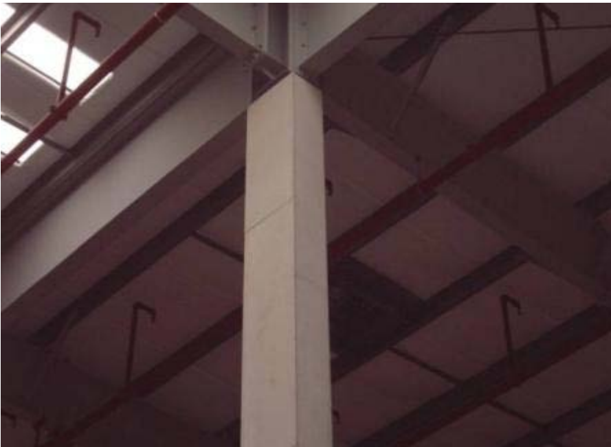
Ilustración 306, Encajuelado de Protección aplicado a estructuras de perfiles de acero estructural
