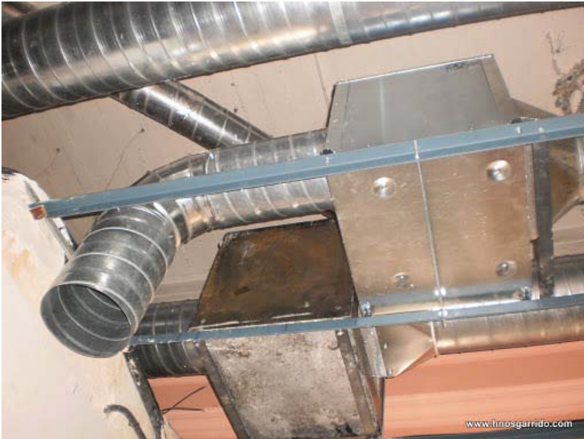
Ilustración 361, Equipo de extracción por aspiración de humo
