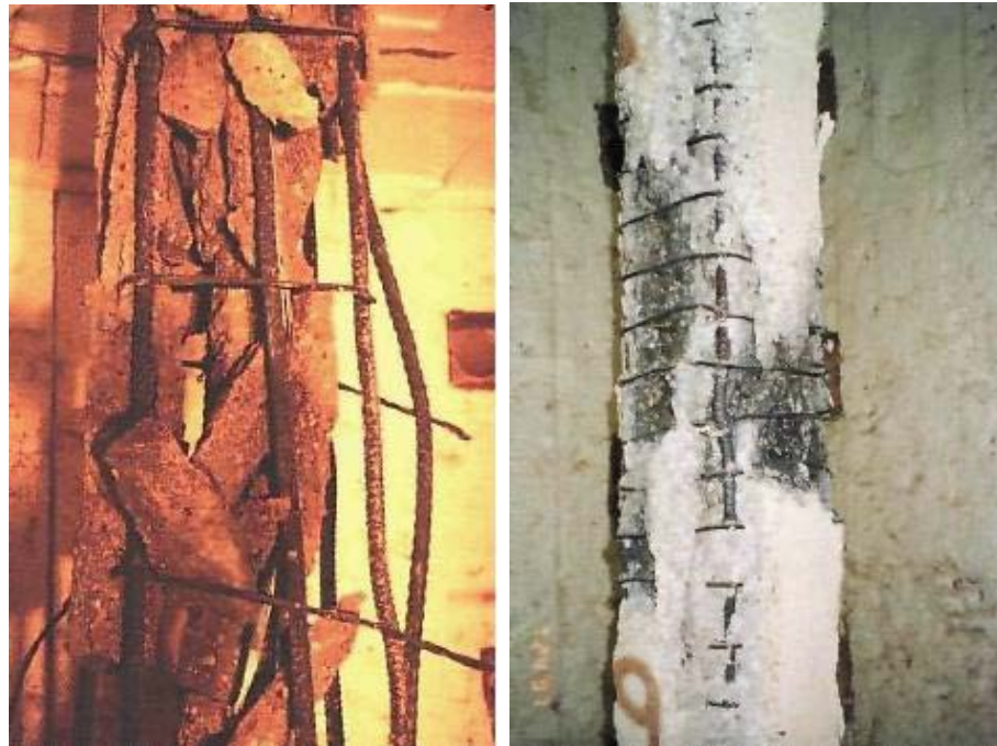
Ilustración 54, efectos del fuego en concretos de alta resistencia
