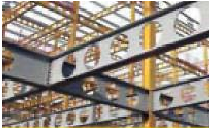
Ilustración 80, Estructura de Vigas Celulares de acero
