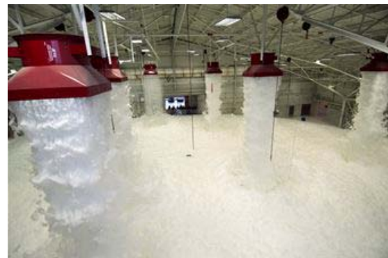
Ilustración 211, equipos tipo Ventury instalados en techo
