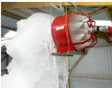
Ilustración 211, equipos tipo Ventury instalados en techo
