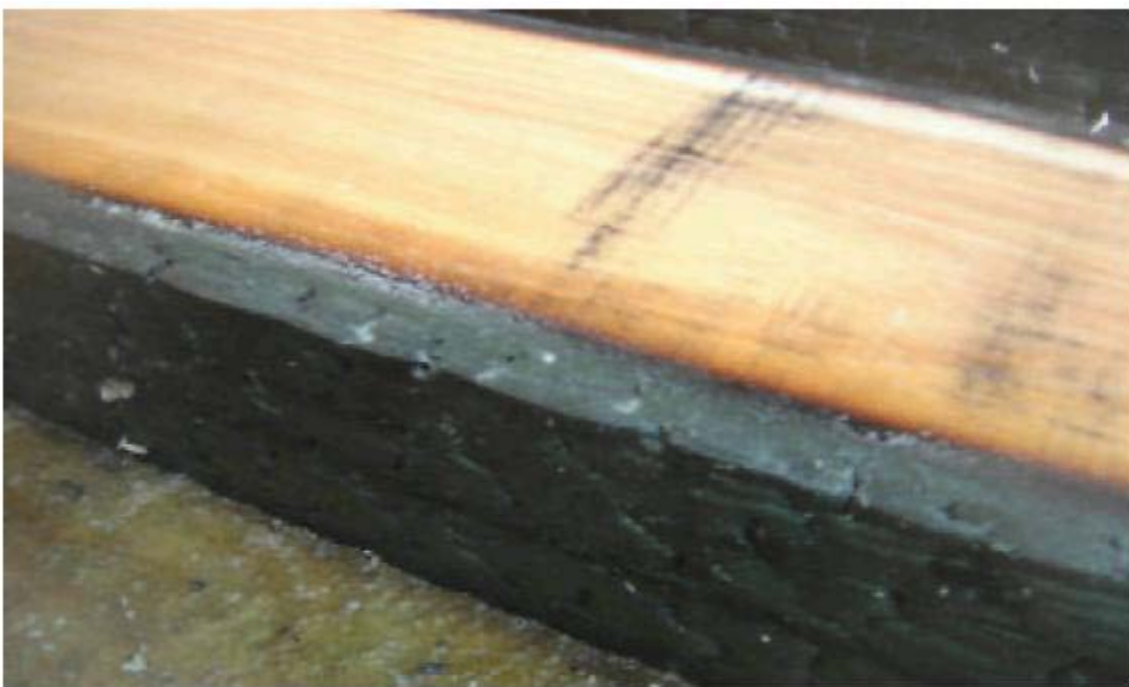
Ilustración 109, efecto de carbonización en una viga de madera expuesta a fuego, nótese la sección residual
