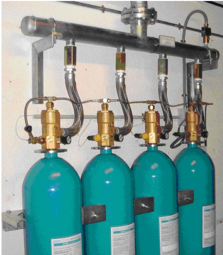
Ilustración 225, botellas de alta presión de dióxido de carbono
