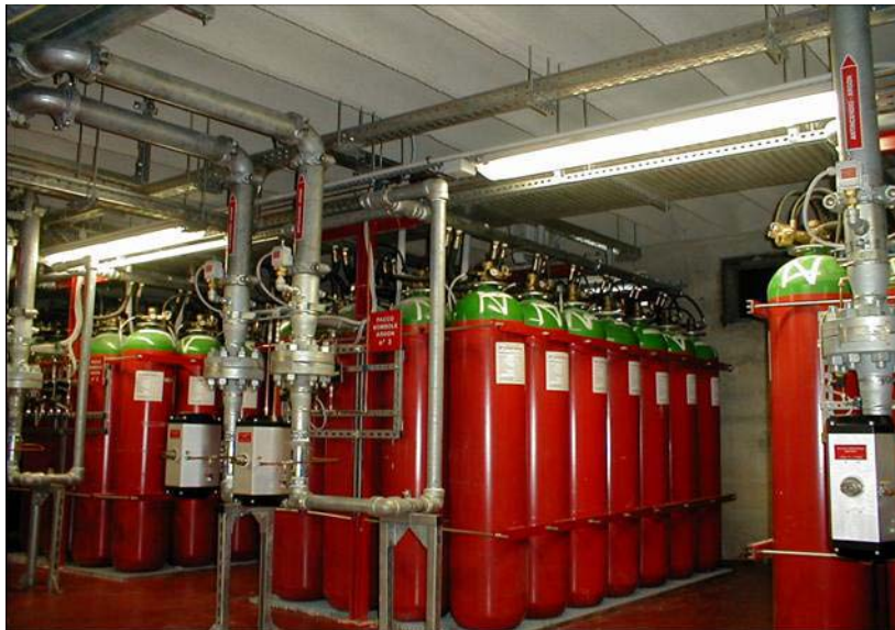
Ilustración 237, banco de almacenamiento de bromotrifluorometano
