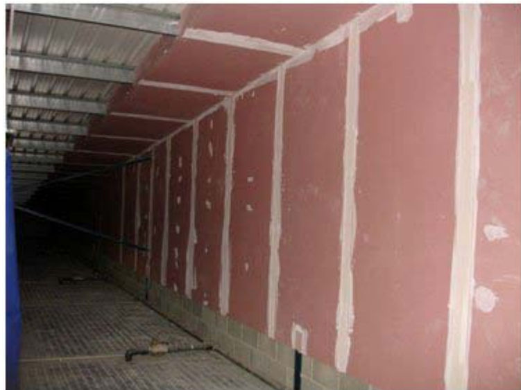
Ilustración 396, las rutas de escape horizontal, deberán de estar aisladas y compartimentadas, de tal manera que sean seguras en todo momento, evitando perforaciones innecesarias, y proporcionando las medidas de seguridad mínimas mencionadas
