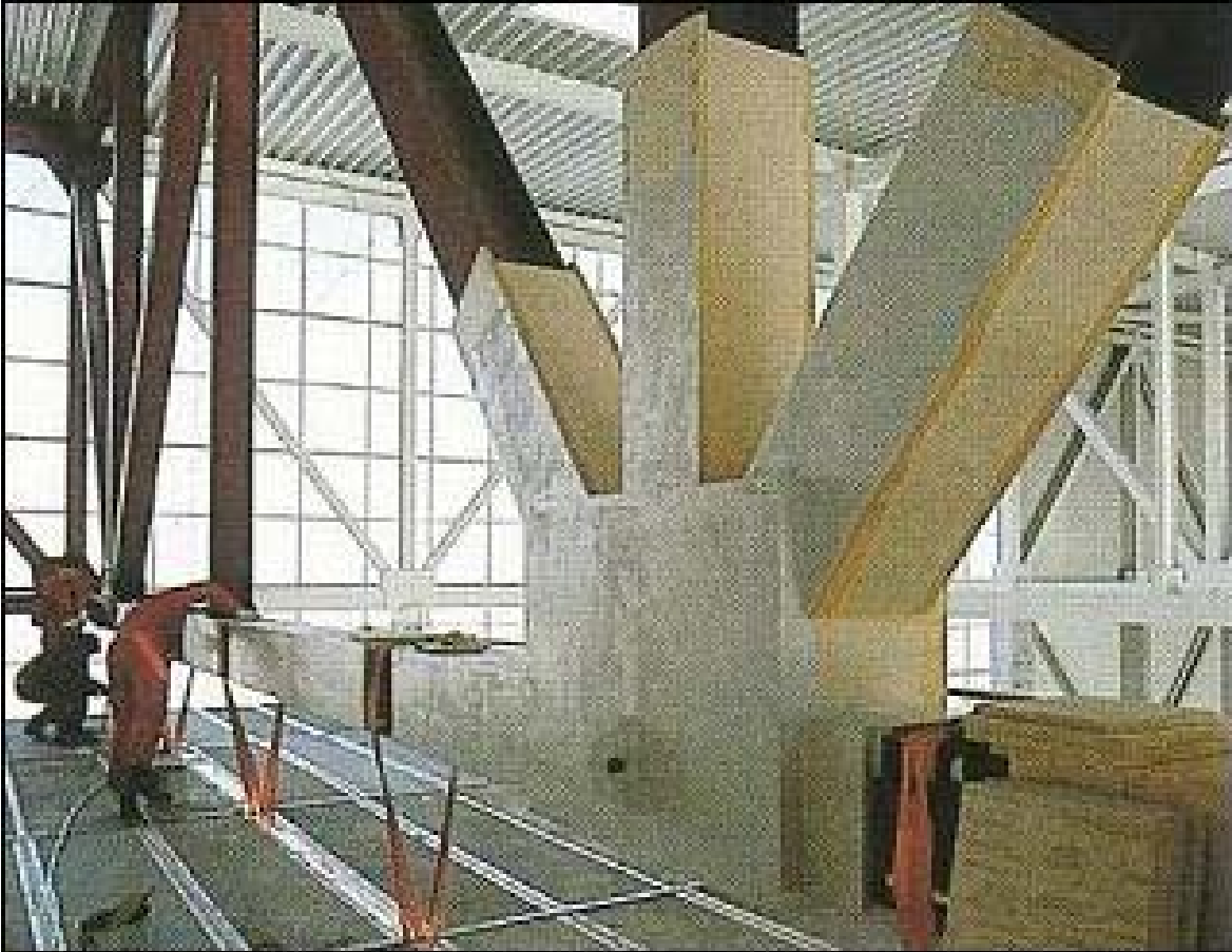
Ilustración 306, Encajuelado de Protección aplicado a estructuras de perfiles de acero estructural
