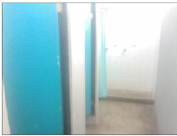
Foto No. 13. Área de sanitarios.
