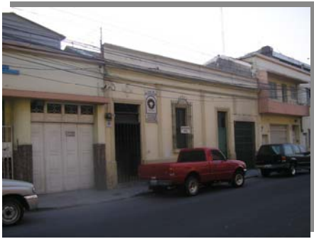
Foto No. 15 Ingreso casa de Rehabilitación Judá Fuente: elaboración propia según visita.
