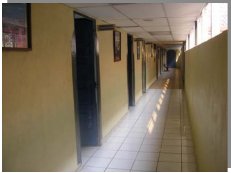
Foto No. 9 Pasillo del área de oficinas Fuente: elaboración propia según visita.
