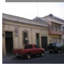
Foto No. 23 Fachada principal en donde se observa los detalles arquitectónicos de la misma (vanos de puertas, detalles de ventanas y la moldura del remate de la fachada.) Fuente: elaboración propia según visita.
