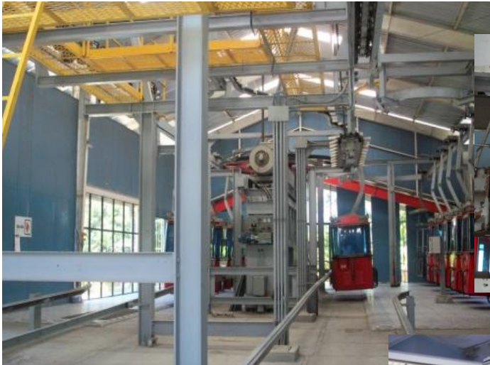
HANGAR CONTRA ESTACIÓN EL FILÓN
