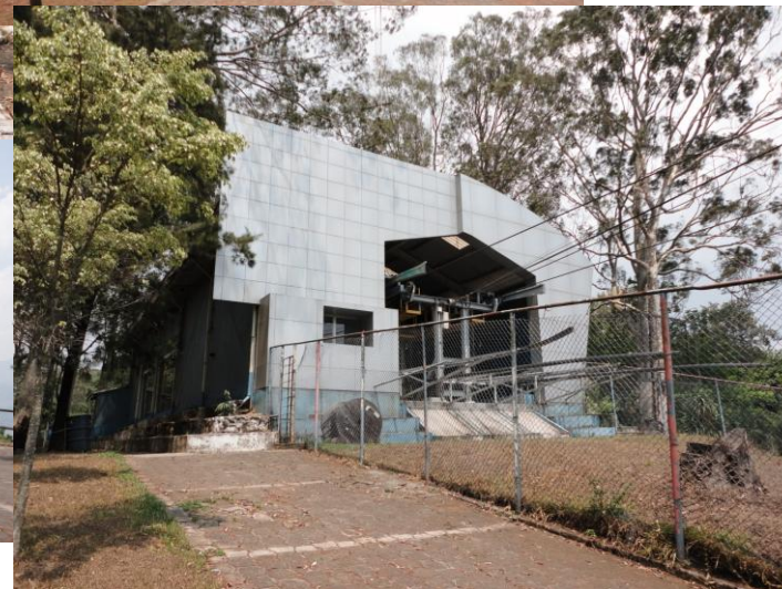
FACHADA PRINCIPAL , HANGAR CONTRA ESTACIÓN
