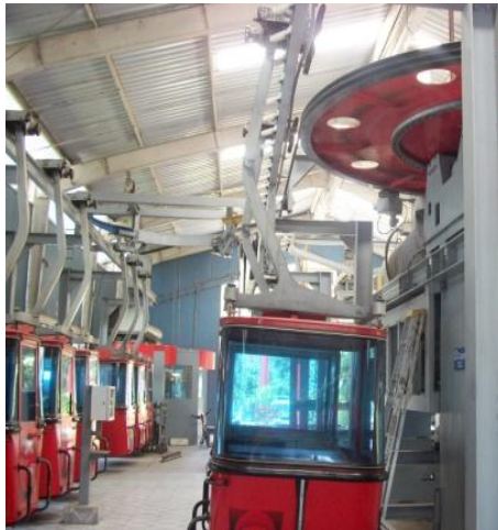
HANGAR ESTACIÓN MOTRIZ LAS NINFAS
