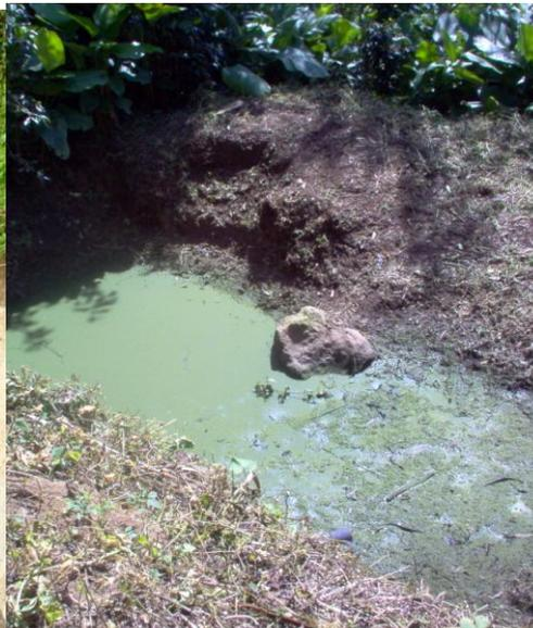
Foto XXI: Laguna de oxidación de aguas mieles. se aplica cal para neutralizar el pH.
