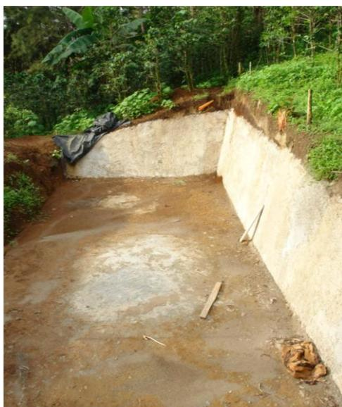
Foto XX: Tanque de evaporación de aguas residuales mieles, donde se depositan las aguas procesadas.
