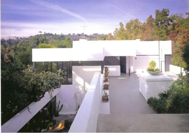
Casa de reposo (Casa Lovell), Lós Angeles, E.E.U.U. 29
