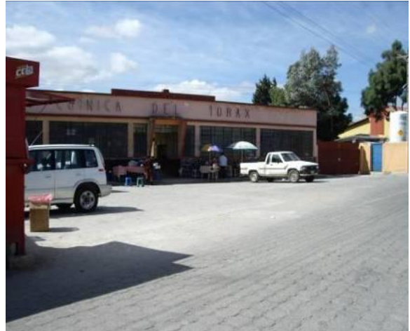
Fotografía No. 12 Frontispicio Consulta externa Hospital Dr. Rodolfo Robles Fuente: Propia
