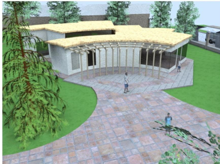
VISTA AEREA ADMINISTRACION CENTRO RECREATIVO Y DEPORTIVO EL PALMAR, QUETZALTENANGO
