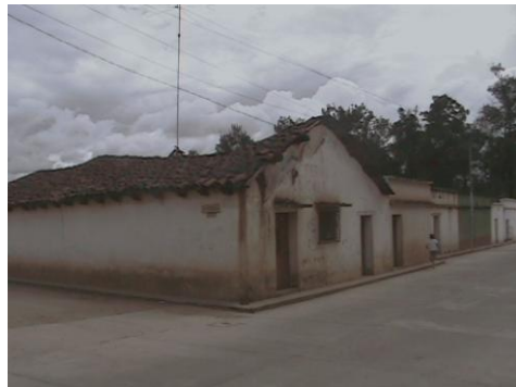
Vivienda de adobe y teja en zona urbana.
