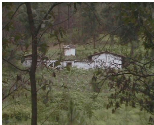
Vista de sur a norte
