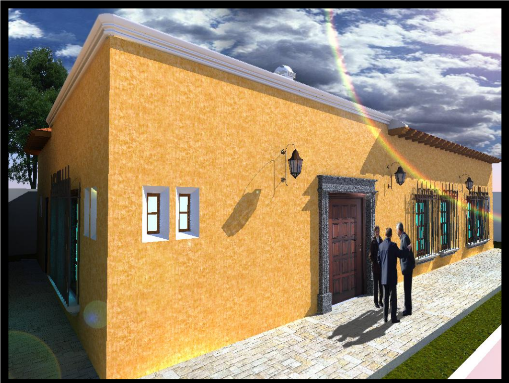
FACHADA NORTE CASA PARROQUIAL
