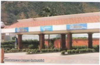
Autotallerías Banco Industrial
