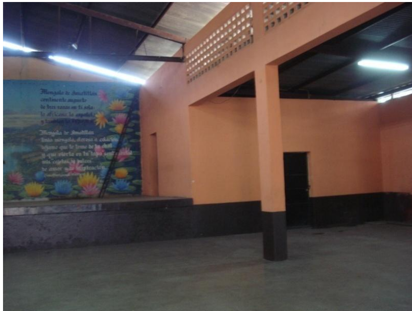
Foto27. Vista interior, columnas interiores existentes, al fondo vestidores.
