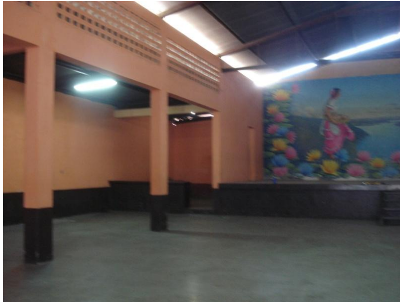
Fotografía 26. Vista interior, columnas interiores existentes, al fondo la cocina.
