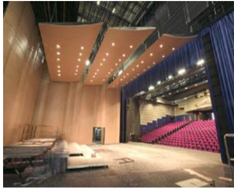
Fotografía 3. Techo acústico – paneles.
