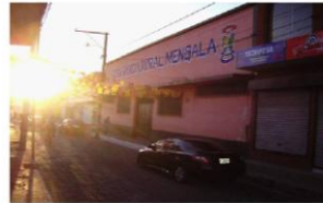
F3 VISTA FACHADA LADO ESTE
