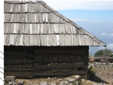
Foto. No. 73 Fecha: 2010 Fuente: Propia Cubiertas inclinadas y muros de piedra del lugar.
