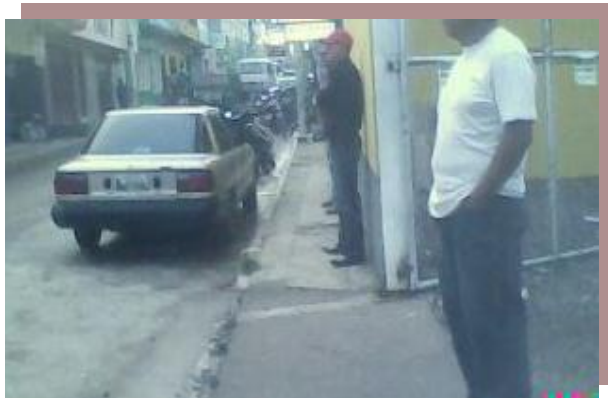
Fotografía N.33 Se observa aceras en mal estado
