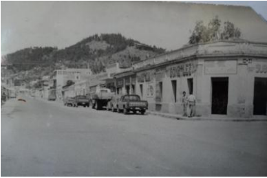
Calzada 15 de Septiembre, cuando no había arriate al centro de la calzada.
