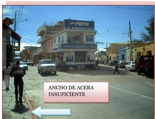
Fotografía N. 37 Estado actual de las aceras
