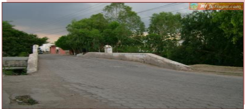
Fotografía N.22 Calle de segundo orden .Nótese que esta Pavimentada con adoquín
