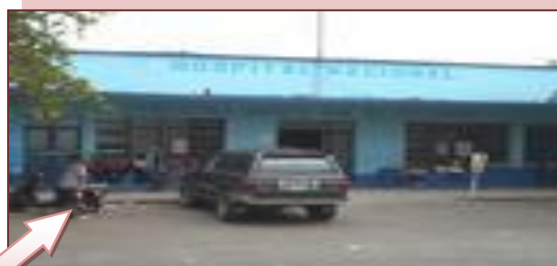
Fotografía N.54 Hospital Nacional Se ubica basureros y cabinas de teléfono
