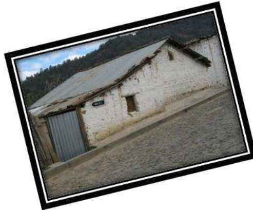
Fotografía 3. Vista de una de las calles empedradas
