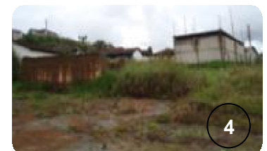
Fotografía 4 - Vista de Construcción Existente en el Terreno
