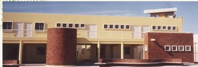
fachada de las instalaciones ilustración 24 arquitectura penitenciaria México
