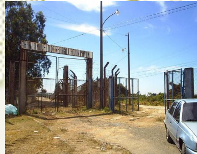
Ilustración 21 Ingreso principal a las instalaciones
