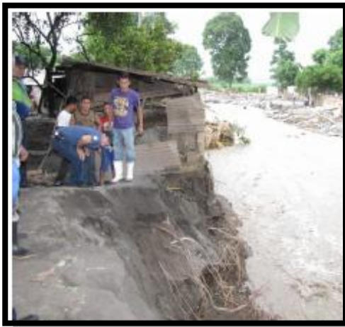
Imagen 1. VIVIENDA DEL BARRIO SAN RUFINO COCALES, Ubicada en las orillas del Rio Madre Vieja. En esta fotografía se observa que las viviendas están construidas en zonas de riesgo.
