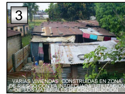
INADECUADA UTILIZACIÓN DE LOS MATERIALES EMPLEADOS EN LA CONSTRUCCIÓN
